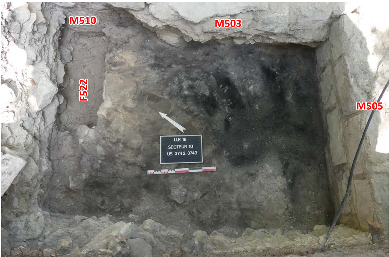
Figure 82 : Photographie de l'US 3742 marquant le démontage de la structure en bois F522
