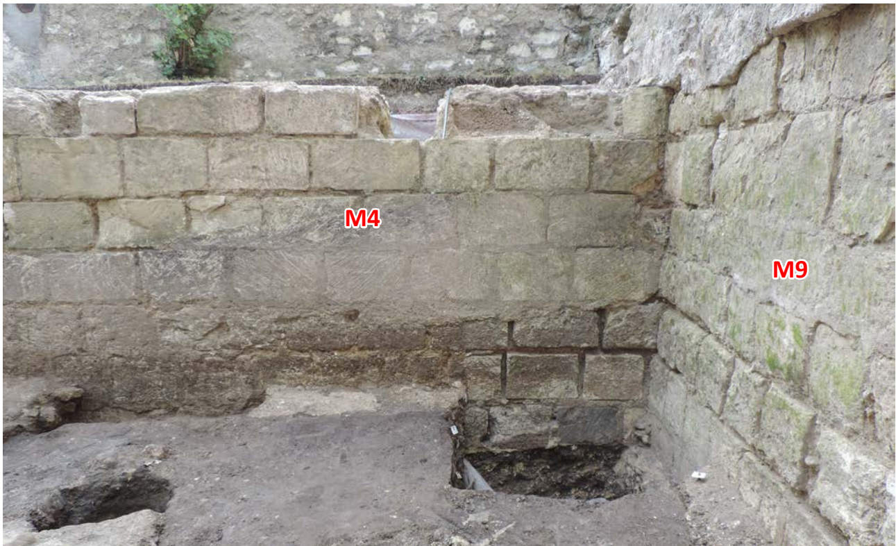
Figure 61 : Murs M4 et M9 dégagés en 2016 (seule la partie basse du mur M4 et le mur M9 date du premier état du bâtiment de la grande salle)
