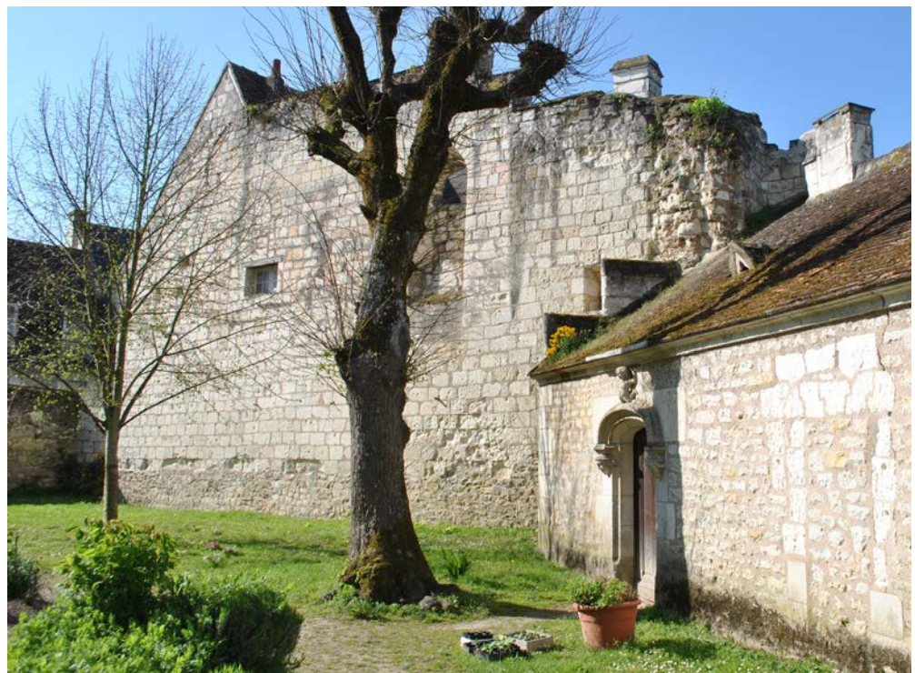
Figure 7 : Photographie du « mur à fenêtres romanes » (2015)
