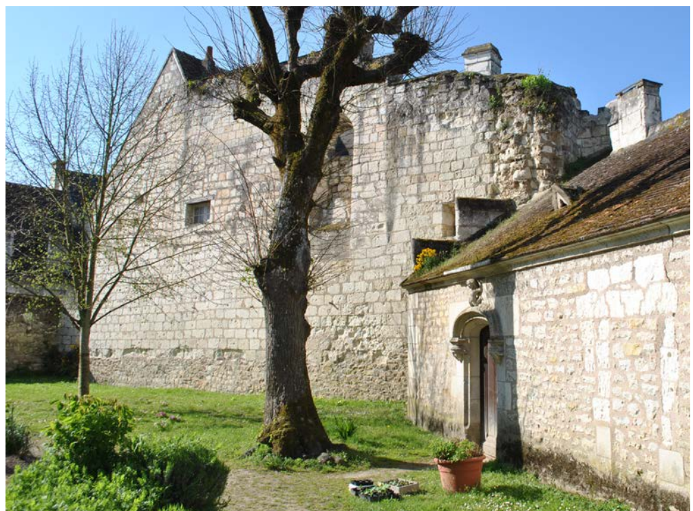
Figure 7 : Photographie du « mur à fenêtres romanes » (2015)
