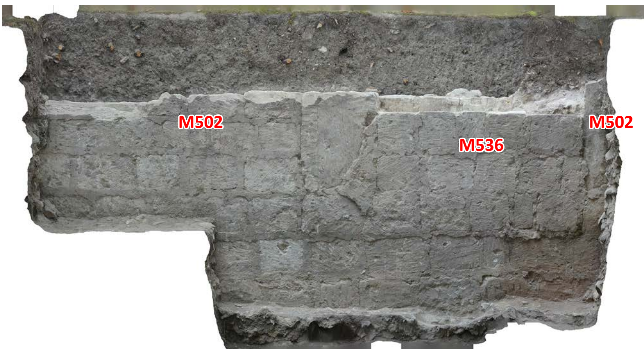
Figure 78 : Orthophotographie du mur M502 (M536)
