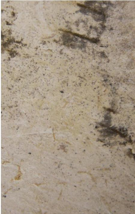
Le ciseau peut parfois se confondre avec le marteau taillant lorsque les traces semblent de grande ampleur (lots 484 et 630). Que le ciseau ou le marteau taillant ait été utilisé pour finaliser la face de parement du lot 484, celle-ci présente les traces d'une taille ciselée oblique qui fut probablement choisie par le tailleur de pierre pour des raisons esthétiques (fig. 21 et 36).
