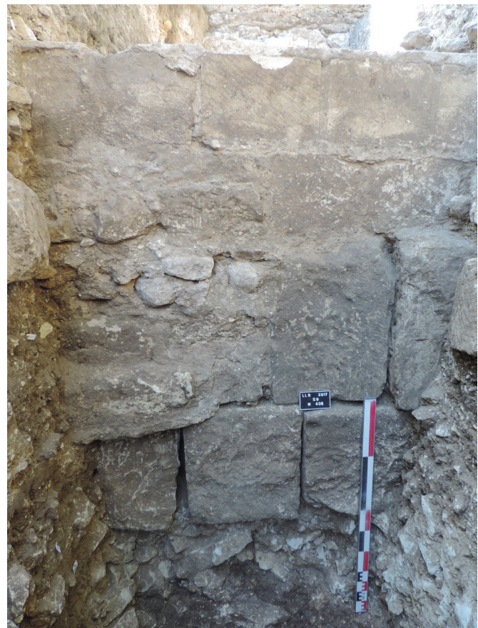
Figure 27 : vue des murs M408, 416 et 443 (parement sud-est)
