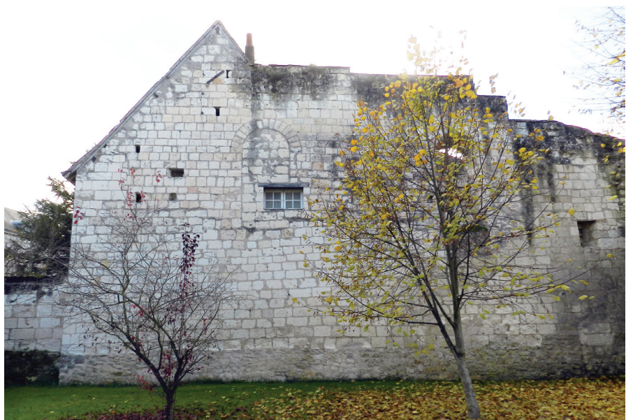
Figure 7 : Photographie du « mur à fenêtres romanes » (2013)
