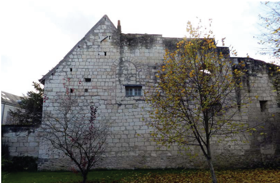
mur M9, état actuel (photo hiver 2013)
