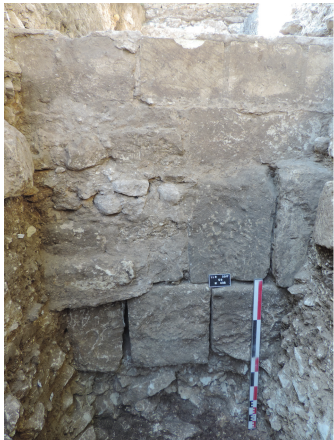
Figure 27 : vue des murs M408, 416 et 443 (parement sud-est)
