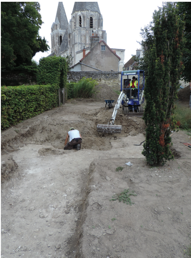
Figure 17 : vue du décapage en cours lors de l'opération de 2017
