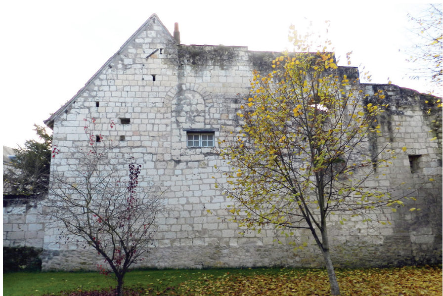
Figure 7 : Photographie du « mur à fenêtres romanes » (2013)
