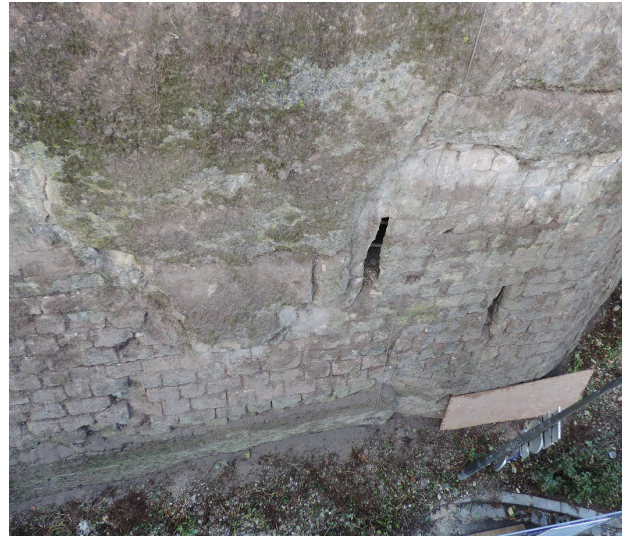
Figure 47 : Archères et parement de la galerie de défense creusée dans un banc tendre du substrat (©Sadil)
