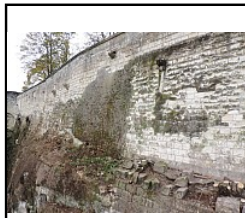
Photo 173 Vue générale - (Riou Samuel)
