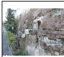
Photo 174 Vue générale - (Riou Samuel)
