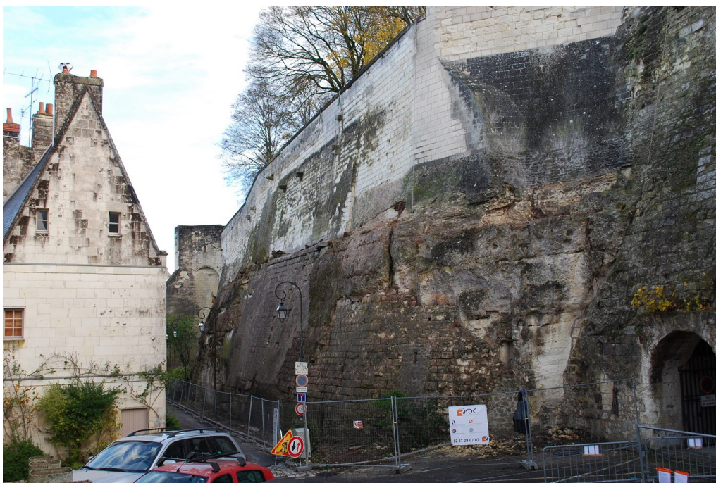
Figure 4 : Vue de la portion de rempart diagnostiquée, après dévégétalisation (©Sadil)
