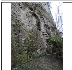
Photo 043 Détail du talus 04 avec archère 56 - (Riou Samuel)
