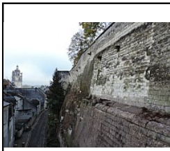
Photo 172 Vue générale - (Riou Samuel)
