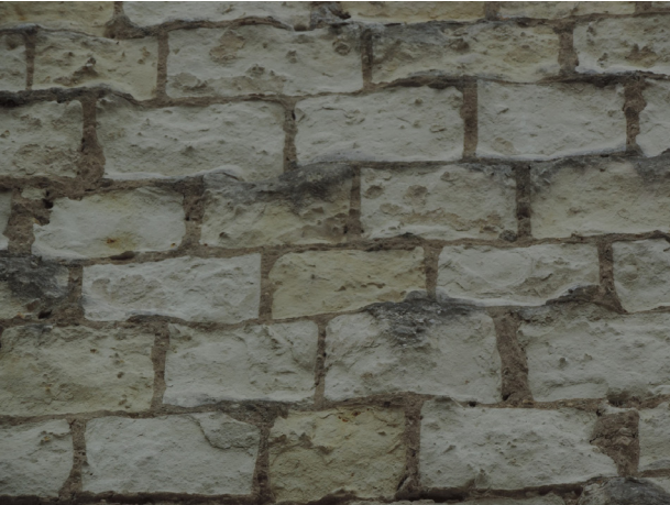
Figure 40 : Exemple d'emploi du tuffeau blanc, « faciès jaune », pour la portion de rempart datée de la fin du 12 e siècle ou du début du 13 e siècle (©Sadil)
