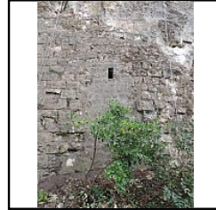
Photo 167 Archère bouchée 53 - (Riou Samuel)
