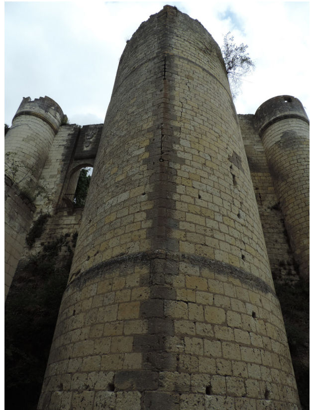
Figure 35 : Exemple d'emploi du tuffeau jaune sur la pointe d'une tour en amande du front sud, datée de la fin du 12 e siècle ou du début du 13 e siècle (©Sadil)
