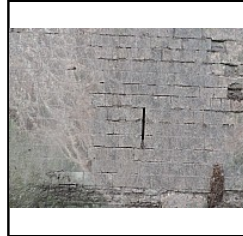
Photo 156 Archère restaurée dans 16 - (Riou Samuel)
