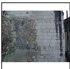
Photo 035 Base de la tour 44 sous contrefort 30 - (Riou Samuel)
