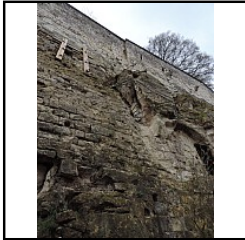
Photo 182 Vue générale (04) - (Riou Samuel)
