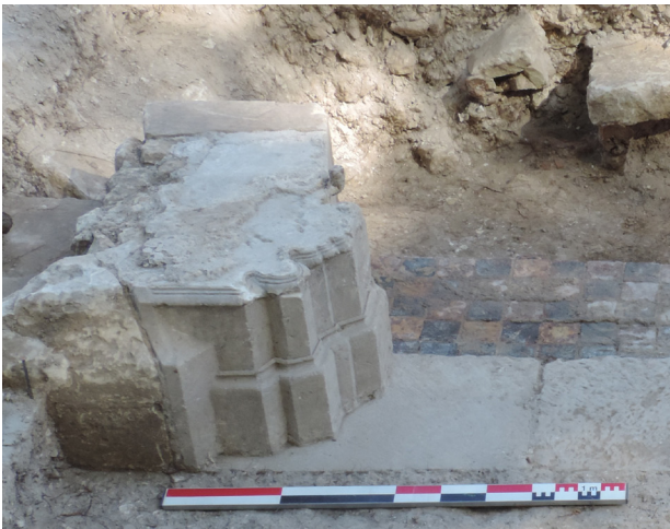
Figure 34 : Exemple d'emploi du tuffeau jaune pour les piédroits de la porte de la chapelle Saint-Louis à la fin du 14 e siècle (©Sadil)
