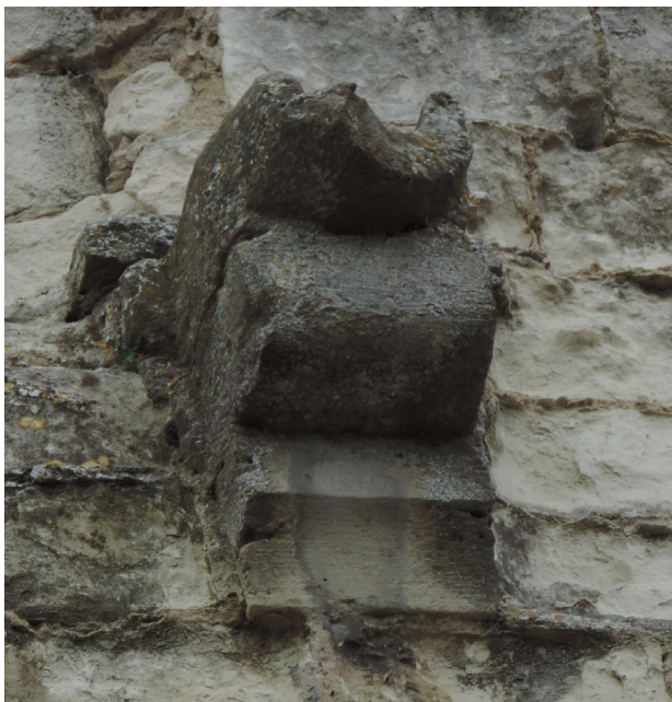
Figure 36 : Exemple d'emploi du tuffeau jaune pour les gargouilles de la portion de rempart diagnostiquée (©Sadil)
