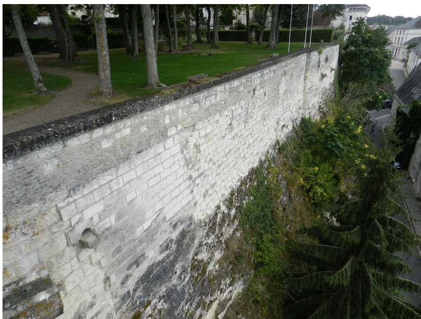
Figure 29 : Vue de la végétation sur la portion de rempart prescrite (©Sadil)
