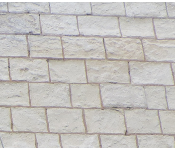
Figure 42 : Exemple de tuffeau blanc sans silex employé dans une des restaurations du 20 e siècle (©Sadil)
