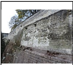
Photo 171 Vue générale - (Riou Samuel)
