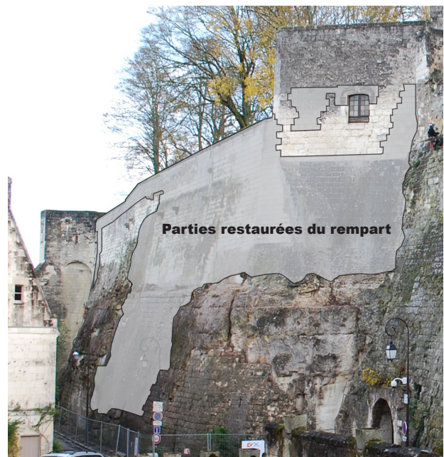
Figure 32 : Parties restaurées du rempart (©Sadil)
