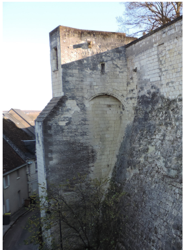
Figure 17 : Contrefort sud-ouest du Fortin , appelé Tour du fortin (©Sadil)
