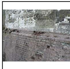
Photo 146 Ressaut remplaçant le rocher - (Riou Samuel)
