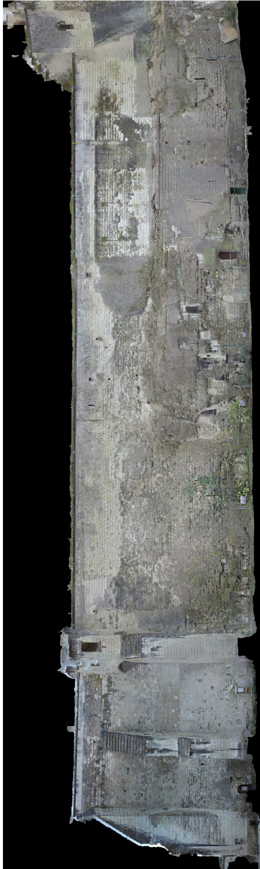
Figure 5 : Orthophotographie de la portion de rempart prescrite (©Sadil)
