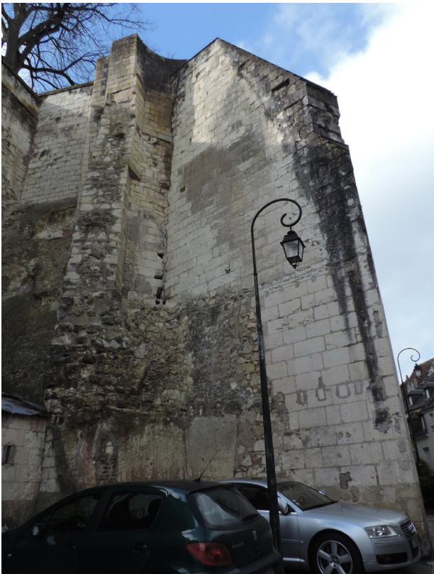
Figure 20 : Vestiges de la tour circulaire du 13 e siècle (©Sadil)
