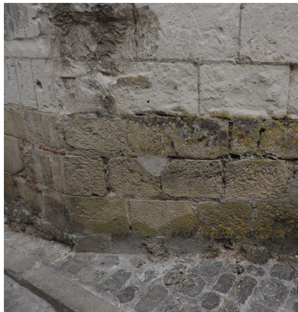
Figure 37 : Exemple d'emploi du tuffeau jaune pour le soubassement du contrefort nord-ouest du Fortin (©Sadil)
