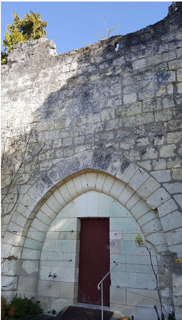
Figure 12 : Porte dans le rempart intérieur et créneaux fossilisés (©Sadil)
