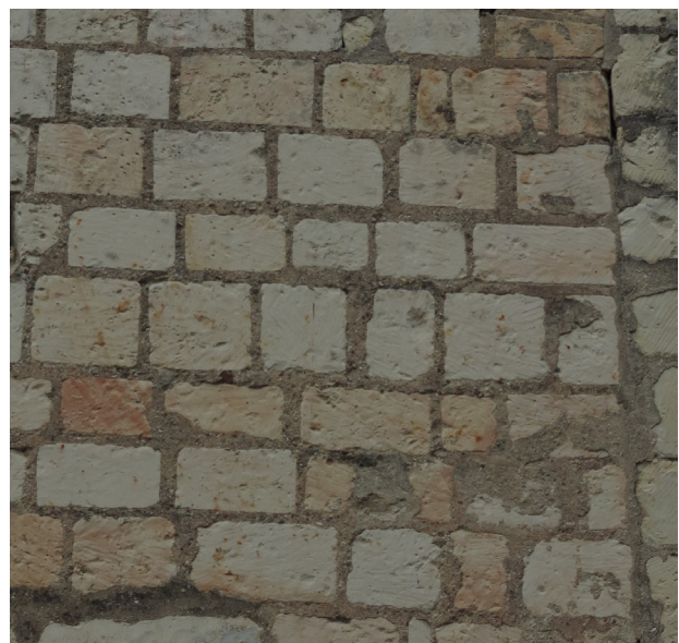
Figure 39 : Exemple d'emploi du tuffeau blanc, « faciès rose », pour le parement de la salle comtale du 11 e siècle (©Sadil)
