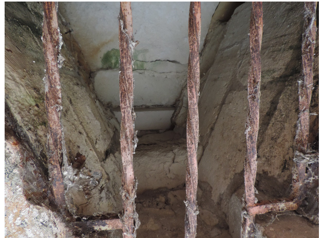
Figure 74 : Vue du dessous des vestiges d'une archère conservés au-dessus de la porte 43 (©Sadil)
