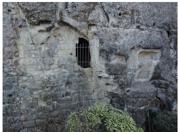
Figure 75 : Vue des vestiges de l'archère 56 (élargie au 19 e siècle) dans la partie sud de l'UA 04 (©Sadil)
