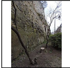
Photo 183 Vue générale (04) - (Riou Samuel)
