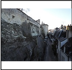
Photo 181 Vue générale - (Riou Samuel)
