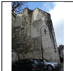
Photo 092 Vue générale de 44 et 30 - (Riou Samuel)
