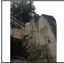
Photo 107 Vue générale de 44 et 30 - (Riou Samuel)
