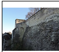
Photo 175 Vue générale - (Riou Samuel)
