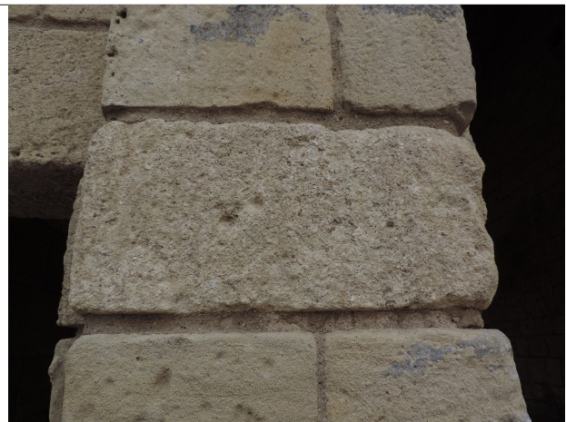
Figure 33 : Exemple d'emploi du tuffeau jaune lors de la reprise du 15 e siècle de la Porte Royale (©Sadil)
