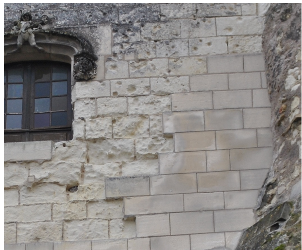
Figure 43 : A droite, tuffeau blanc sans silex dénommé Pierre n°7 sur le calepinage de la restauration du Logis du fou en 1931 (©Sadil)
