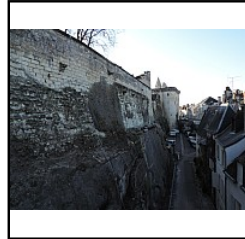
Photo 180 Vue générale - (Riou Samuel)
