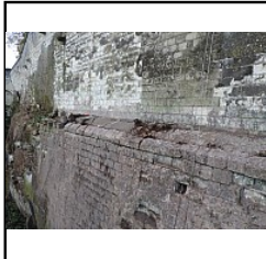
Photo 150 Ressaut remplaçant le rocher - (Riou Samuel)
