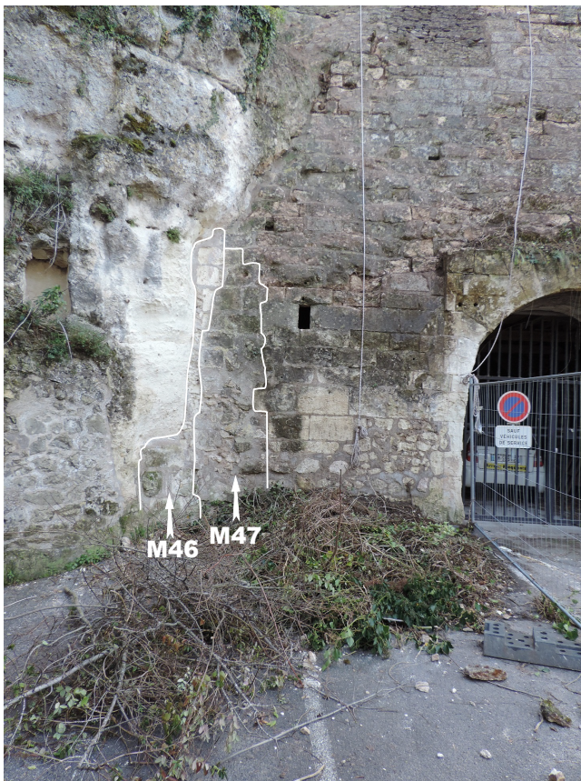
Figure 34 : Vue des restaurations M46 et M47 de la partie nord de la porte cochère P50 (©Sadil)
