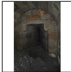
n° photo 044 Archère sous la porte Royale
