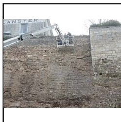
n° photo 056 M09 et M05 en cours de piquetage
