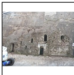
n° photo 059 Bâtiments 4 et 5
