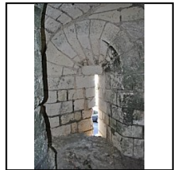
n° photo 045 Archère sous-sol de la tour N de la porte Royale
