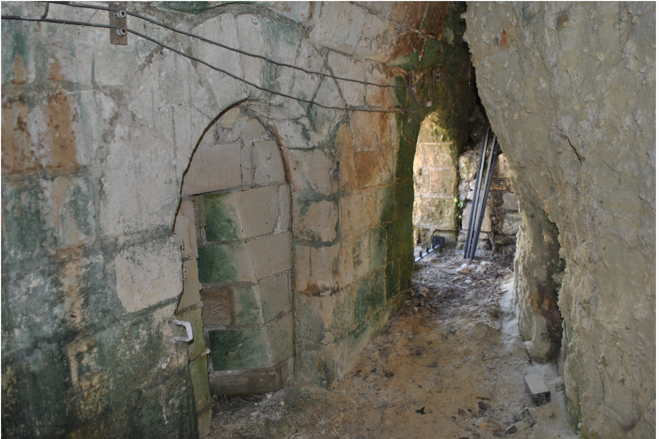
Figure 46 : Vue des archères F58 et F59 depuis l'intérieur de la galerie de défense (©Sadil)
