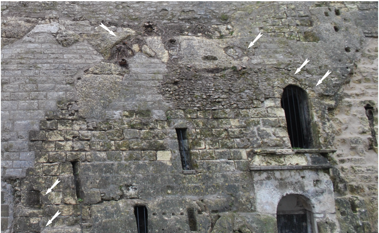
Figure 28 : Vue des traces d'engravement du bâtiment 4 dans la muraille (indiqué par des flèches) (©Sadil)
