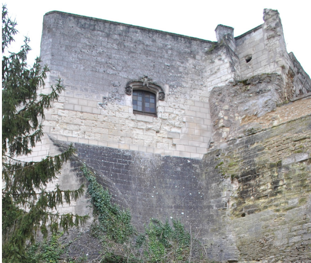
Figure 19 : Vue du Logis du Fou depuis le sud-ouest restauré en 1931
