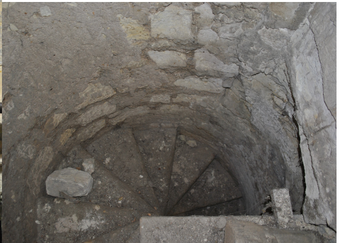
▼ Escalier à vis, menant au chemin de ronde
