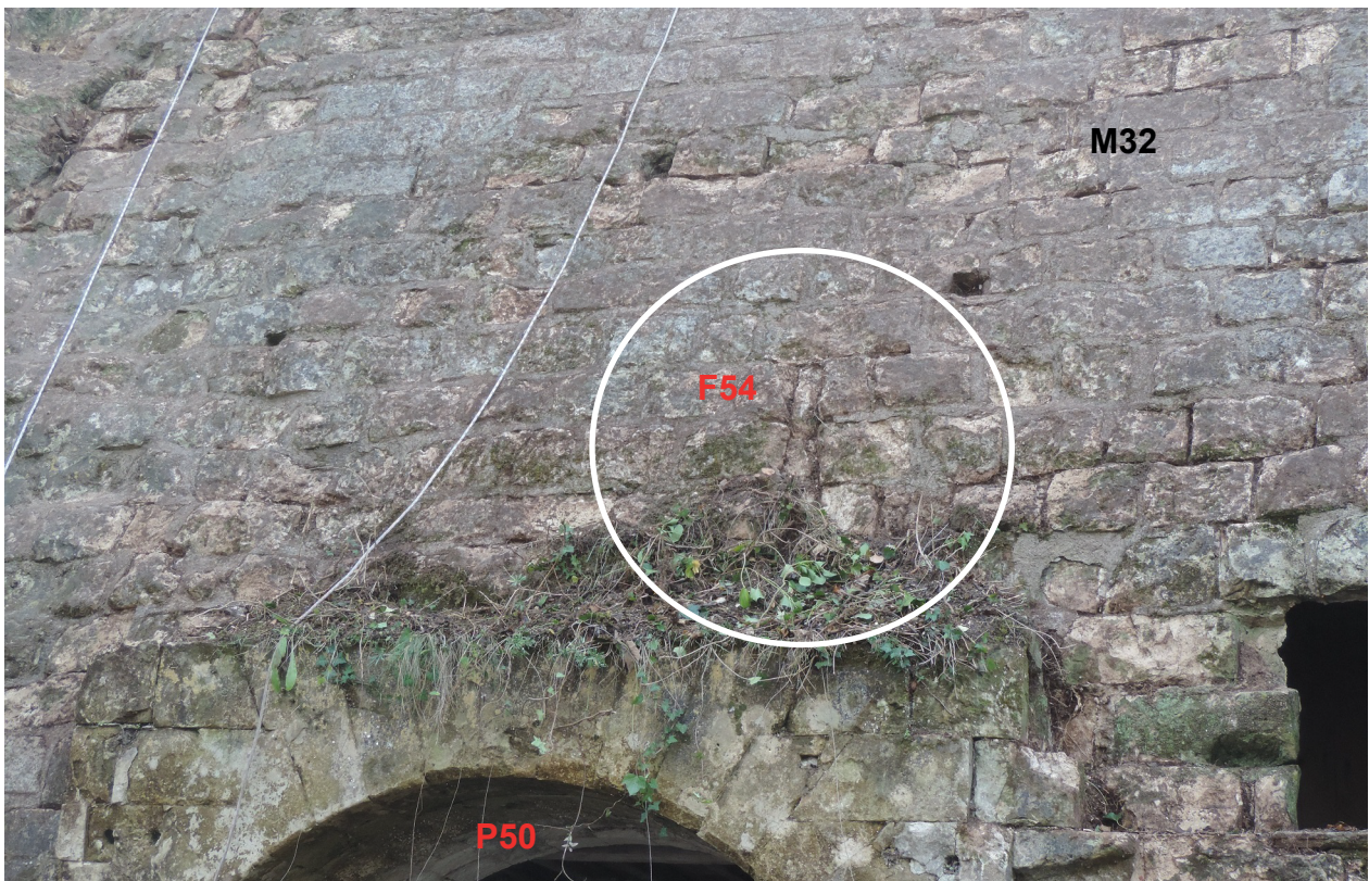
Figure 47 : Vue de la fente de tir bouchée F54 au-dessus de la porte cochère P50 (©Sadil)
