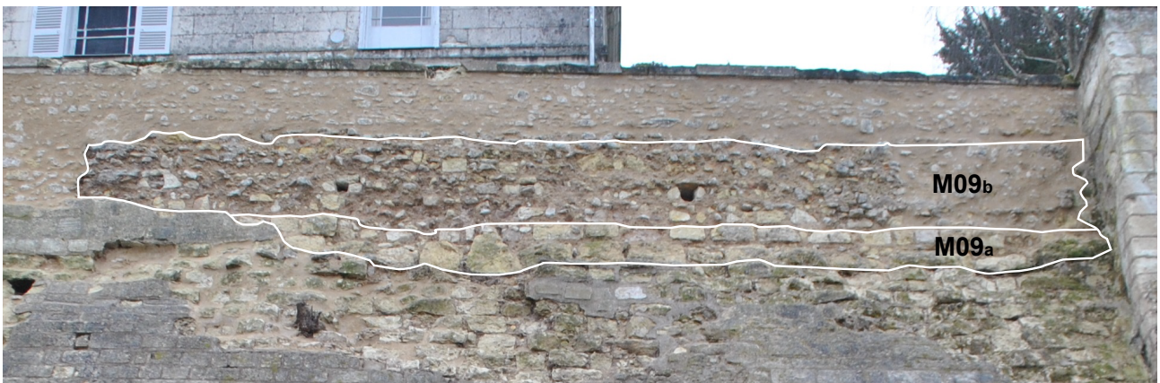
Figure 38 : Vue de M09a (fondations) et M09b (élévation) (©Sadil)
