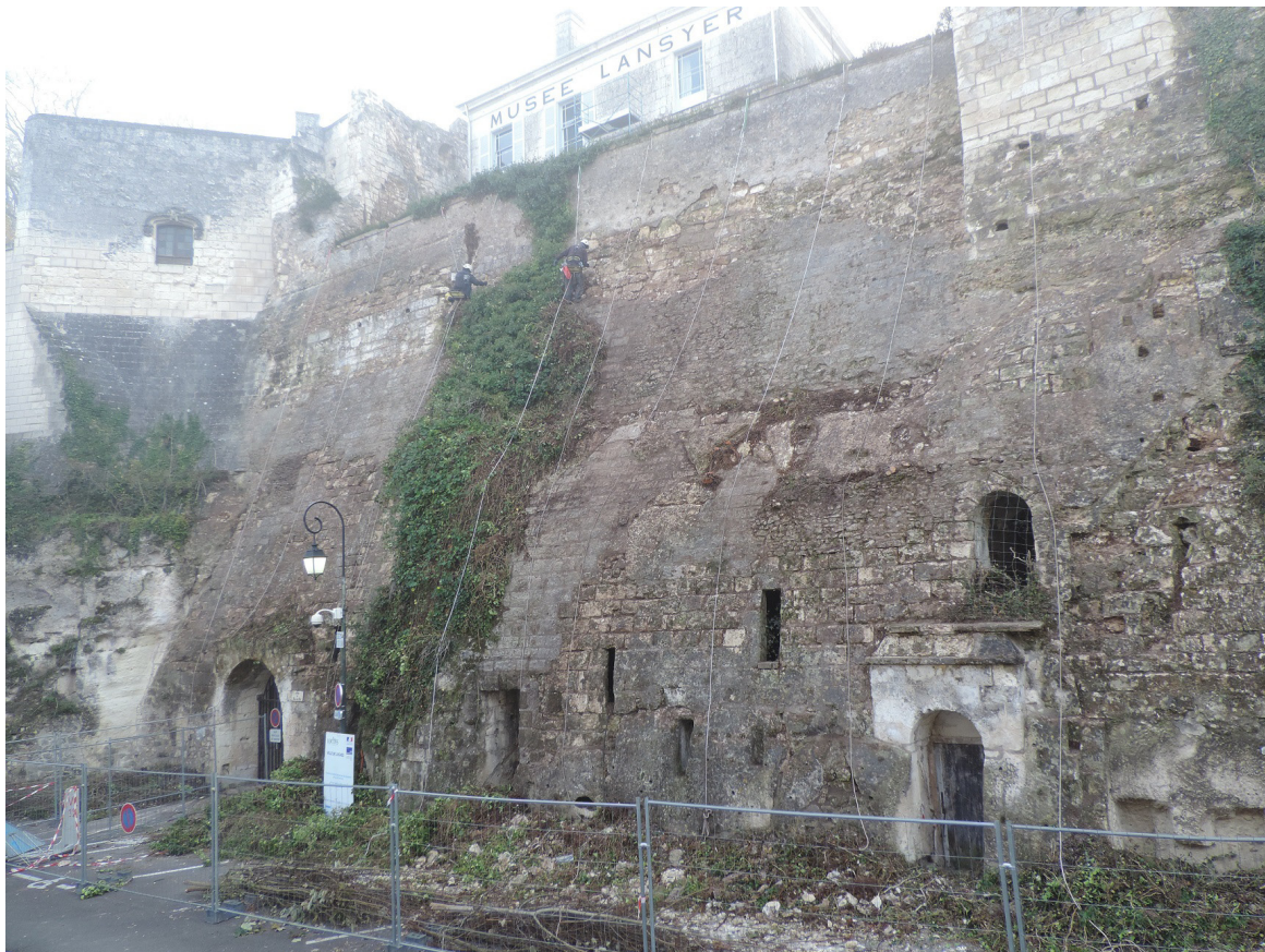
Figure 4 : Vue de la portion de rempart diagnostiquée, en cours de dévégétalisation (©Sadil)
