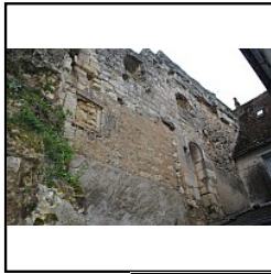
n° photo 031 Revers sud du bâtiment 1
