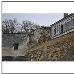
n° photo 027 M01, M02, bâtiment 1, logis du fou
