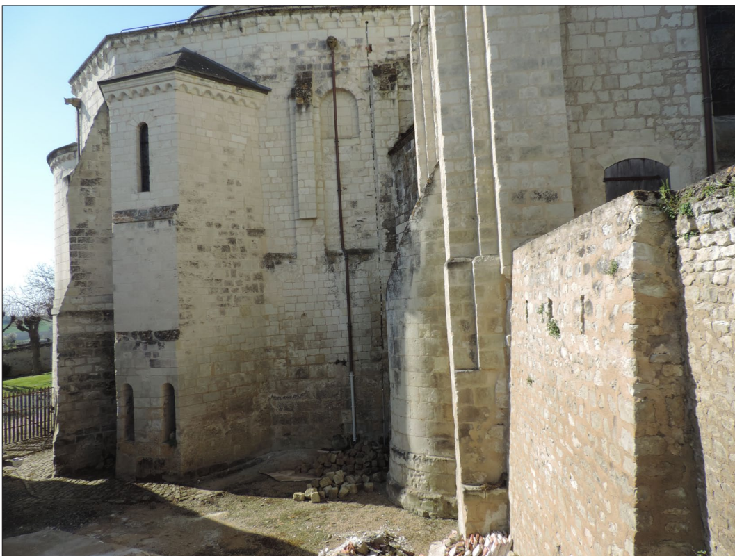
Figure 36 : Vue du parement extérieur de la partie nord-ouest de la collégiale. On note les multiples traces des différentes phases constitutives de l'état actuel du chevet de l'église
