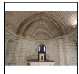
Tranchée : Choeur de la crypte
