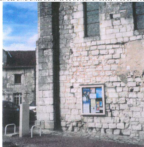
Maçonnerie de la façade sud avant travaux
