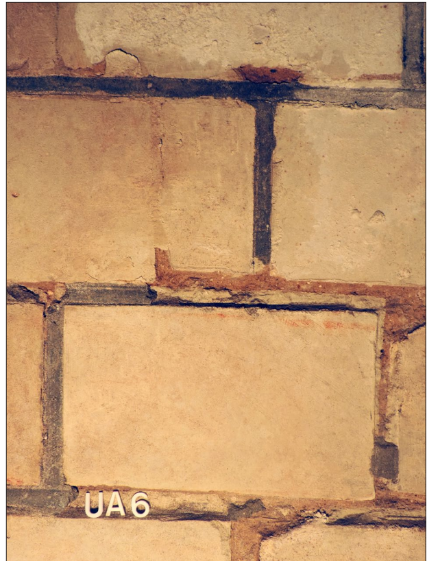
Figure 22 : Détail de la restauration 19 e siècle des parements de la crypte, avec rebouchage des anciens joints au plâtre et creusement d'un faux appareil parfaitement réglé et rejointoyé au ciment
