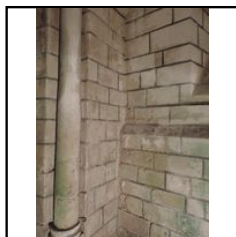
Tranchée : Chapelle orientée de la crypte
