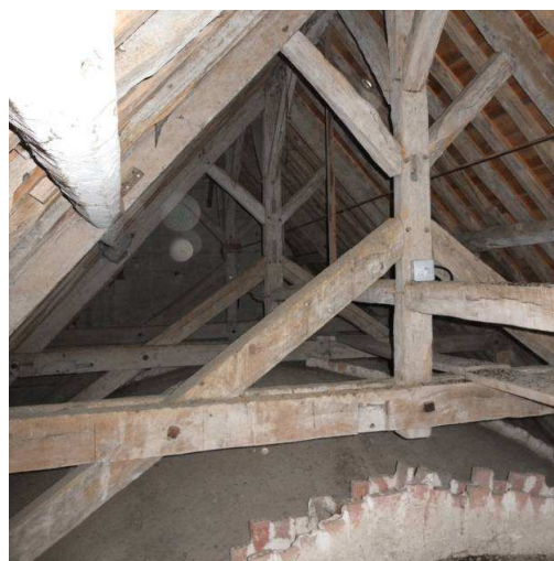
Vue des charpentes de la nef
