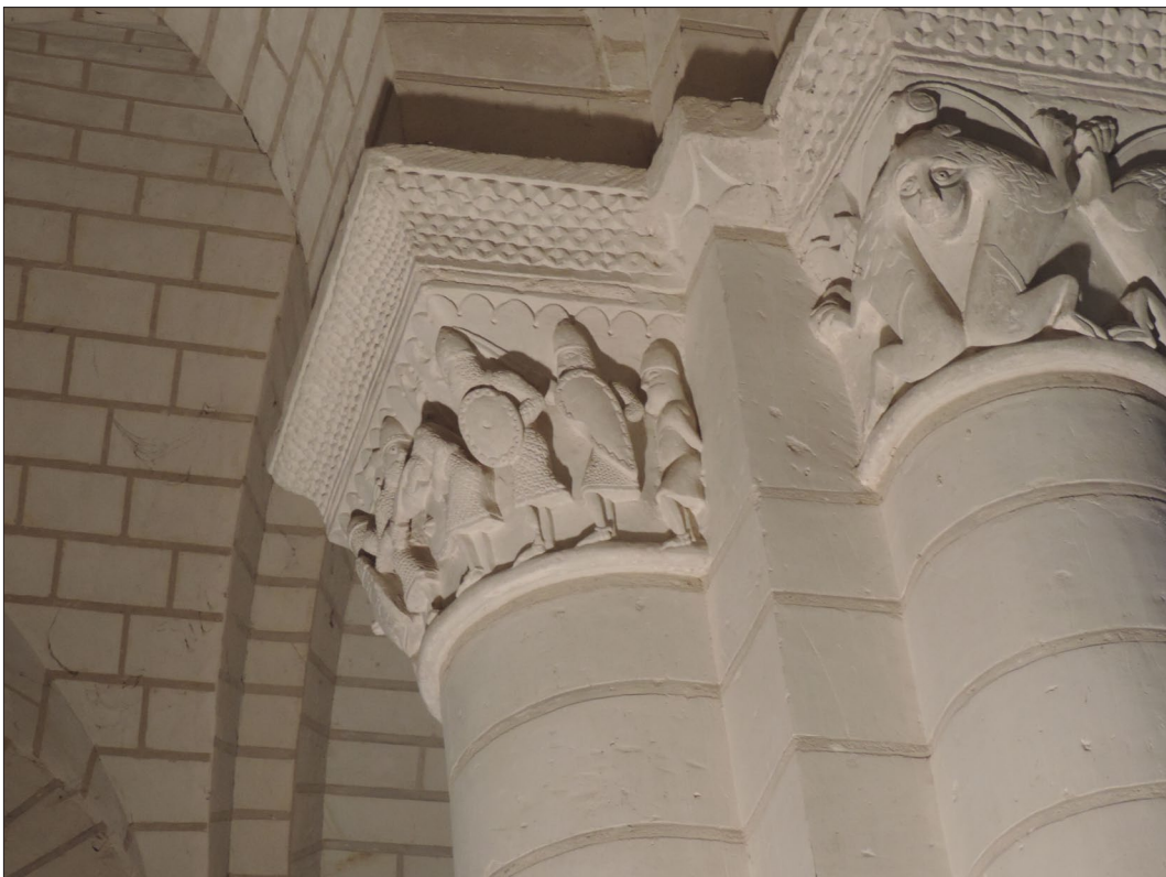
Figure 19 : Vue de l'un des chapiteaux restaurés au 19 e siècle du chœur de la collégiale Saint-Georges
