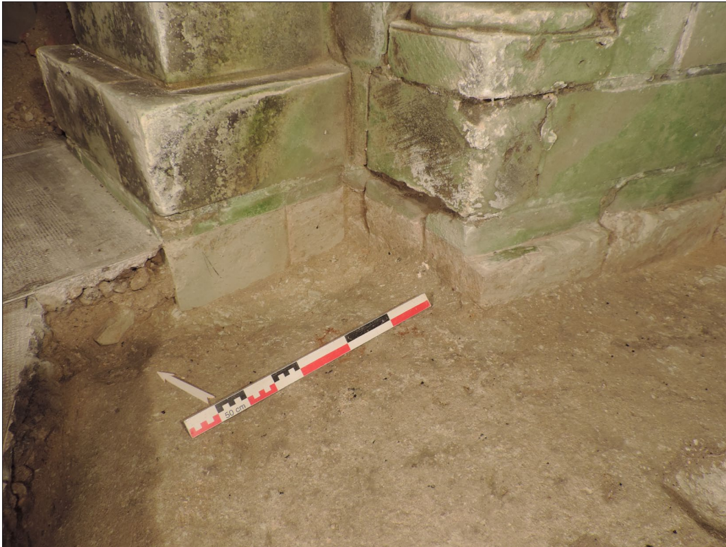
Figure 29 : Vue de la base de colonne reprise en sous-œuvre au 19 e siècle, dans le sondage 3
