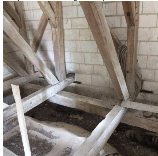
Poutres du beffroi ancrées dans les maçonneries
