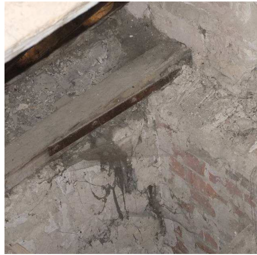
Tirant ancré dans la sablière intérieure angle sud-ouest de la nef
