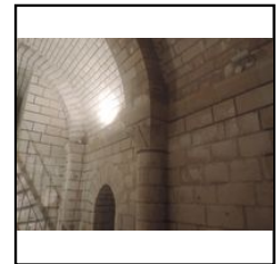
Tranchée : Choeur de la crypte
