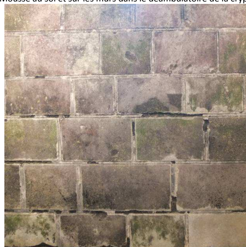
Joints creusés dans le déambulatoire de la crypte
