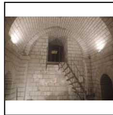
Tranchée : Vue du choeur de la crypte, vers l'ouest.
