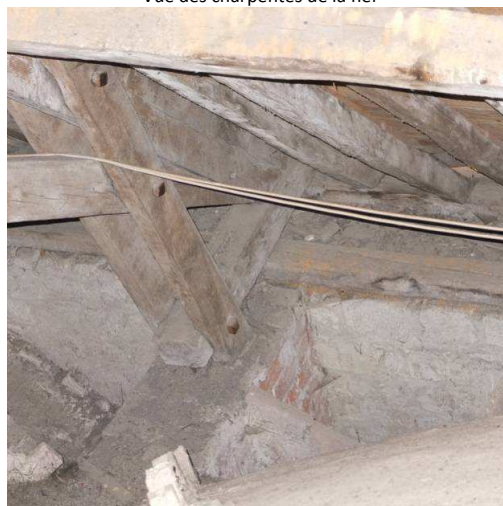
Pied des fermes maîtresses de la charpente de la nef
