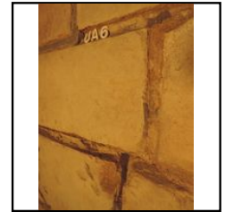
Tranchée : Vue des restaurations du déambulatoire
