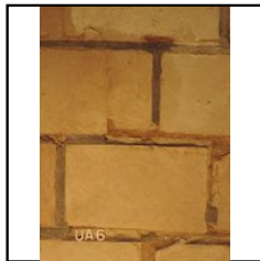
Tranchée : Vue des restaurations du déambulatoire
