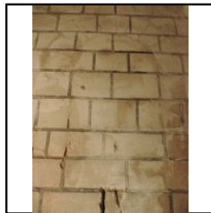
Tranchée : Vue des restaurations du déambulatoire
