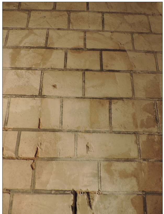
Figure 35 : Vue de la trace de baie romane bouchée dans la partie nord du déambulatoire, à proximité du sondage 4
