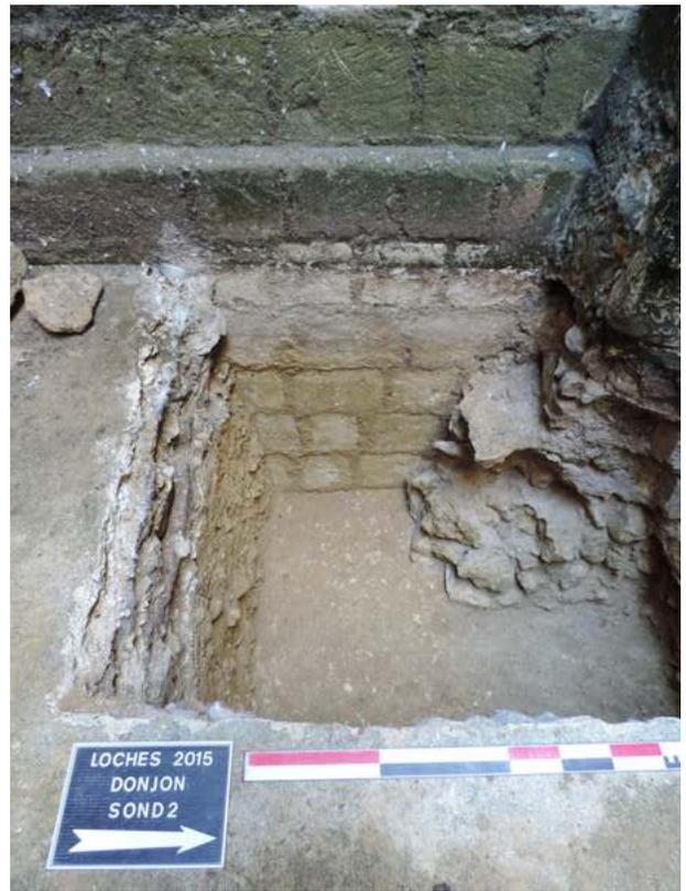
Fig. 16 - Fondation du mur ouest de la tour maîtresse dégagée dans le sondage 2 : parement de moyen appareil très bien conservé (Papin - Sadil)
