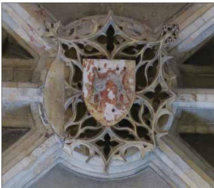
Fig. 15 – Carpentras, cathédrale, clef de voûte des cinquième et sixième travées (c. 1450-1480).
