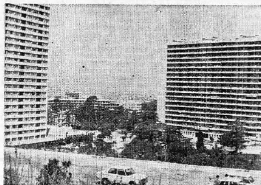
Le problème des charges...
