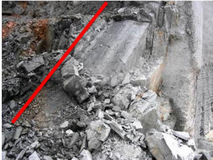
Figure 11 : Contact grès altéré (à gauche) / siltite (à droite) entre la zone 1 et le Sud de la station présentée Figure 10 en cours d'excavation/
