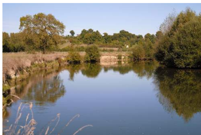
Fig. 12 – État des berges (site de Bruant).
