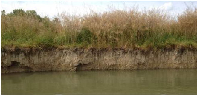
Fig. 3 – Berge limono-sableuse à Cherré (juin 2015).
