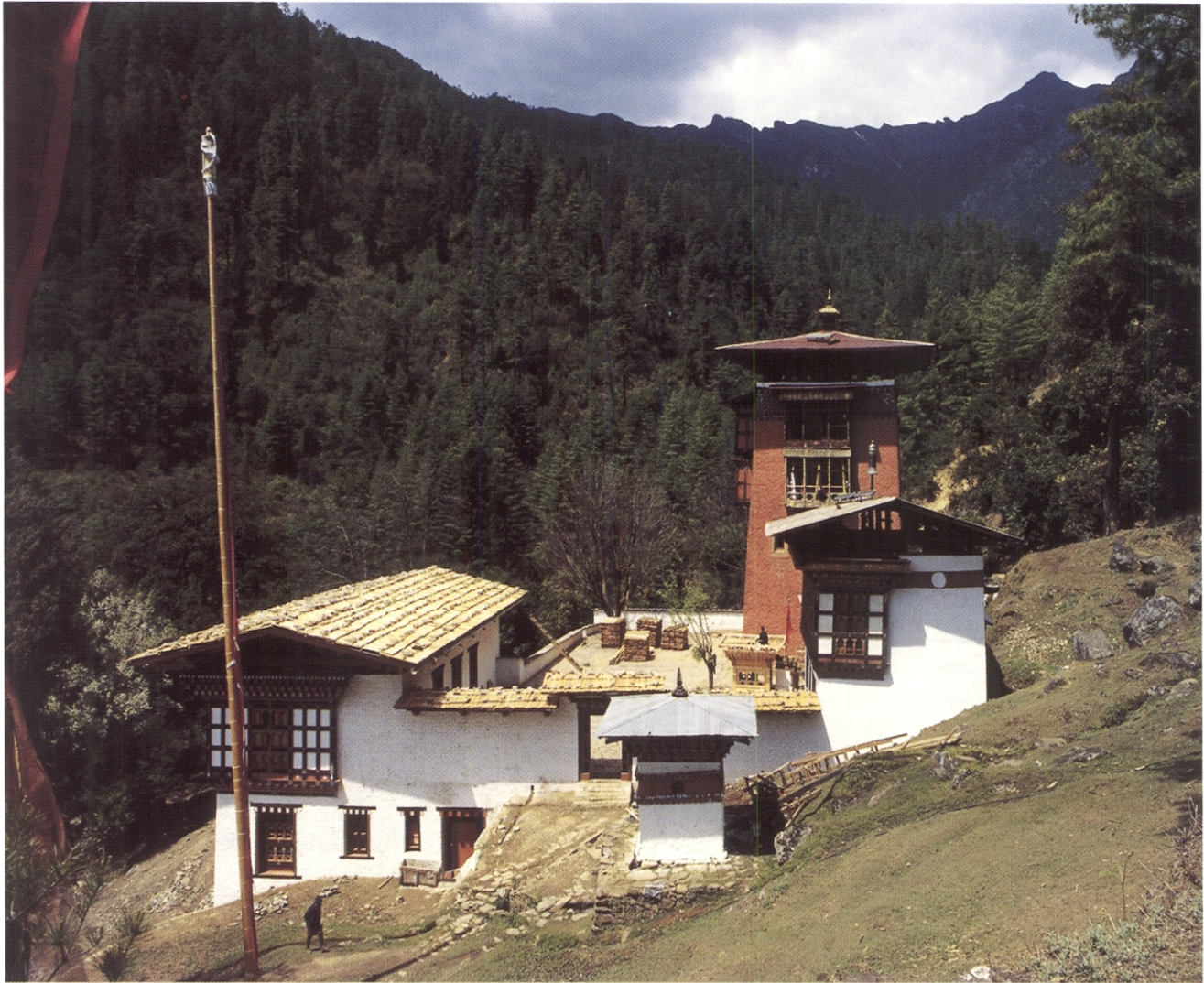
Fig. 11 Le monastère à la fin des travaux (1998).
