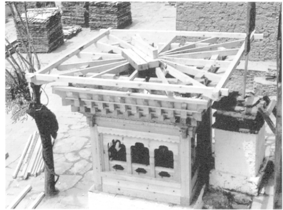
Fig. 14 Le pavillon du rocher sacré, charpente du toit inférieur (1998).
