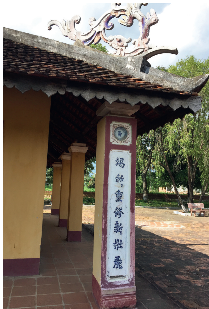
Fig. 6 — Inscription sur la colonne droite de la façade du temple An Khê Trường. Photographie : EFEO, 2019.
