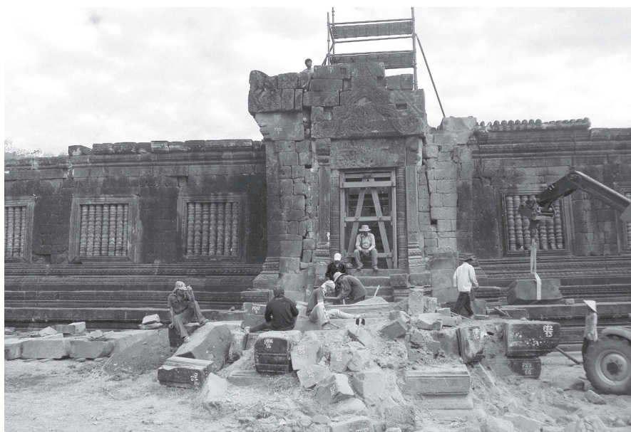
Fig. 4. Porche sud du quadrangle nord, démontage de l'avant-corps en cours (© David Bazin)
