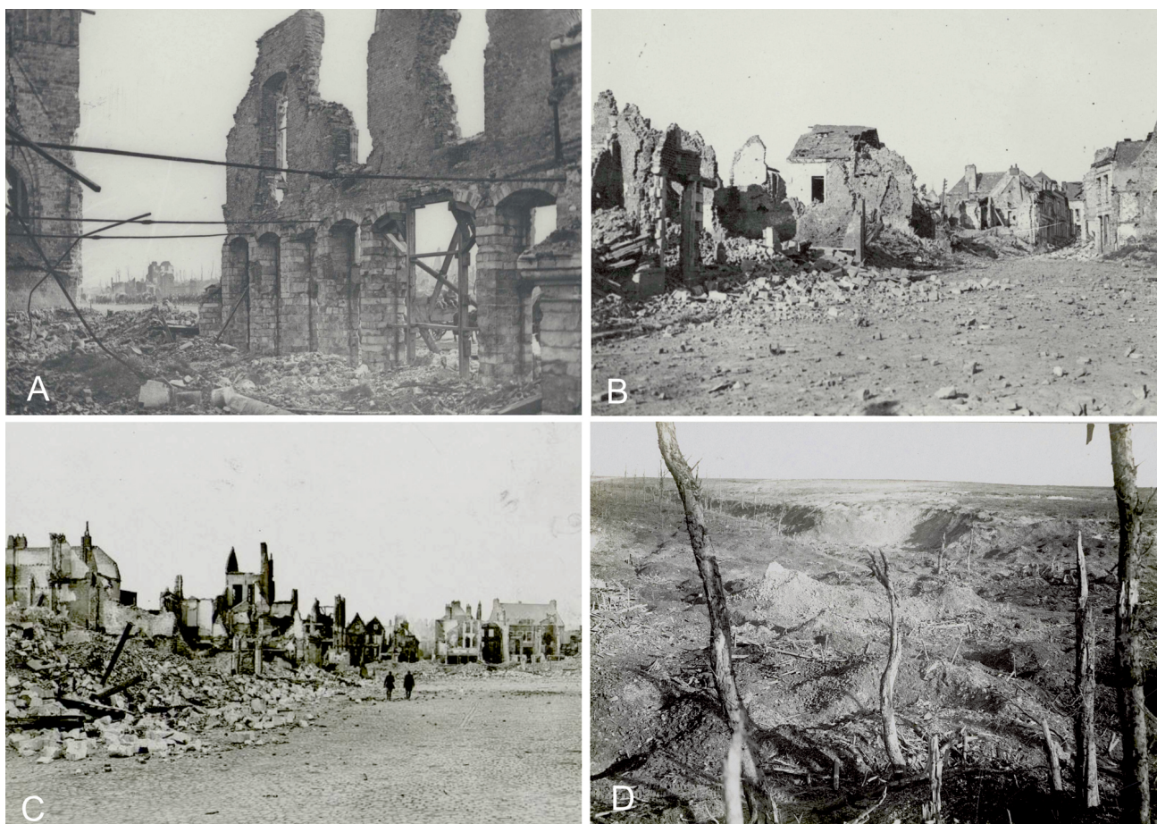
Fig. 6 : Localités détruites sur le trajet de la 3 e étape, état à la fin de l'année 1918. A : Ypres. 1er octobre 1918. La Grand'Place – Les Halles : restes de la façade (vue intérieure) et du beffroi (coll. La Contemporaine VAL 501/105). B : Cambrai. 13 octobre 1918. Place d'Armes – Maisons minées et incendiées par les Allemands (coll. La Contemporaine VAL 236/132). C : Bapaume. 7 septembre 1918. La Grand'Rue en partie incendiée et minée par les Allemands (coll. La Contemporaine VAL 297/156). D : Beaumont-Hamel, 26 novembre 1916. Partie du village. Au centre l'emplacement de l'Église. Cliché British official photo. Q 1526 (coll. La contemporaine VAL 436/029). On peut voir à l'arrière-plan le cratère d'une mine ayant explosé en juillet 1916.
