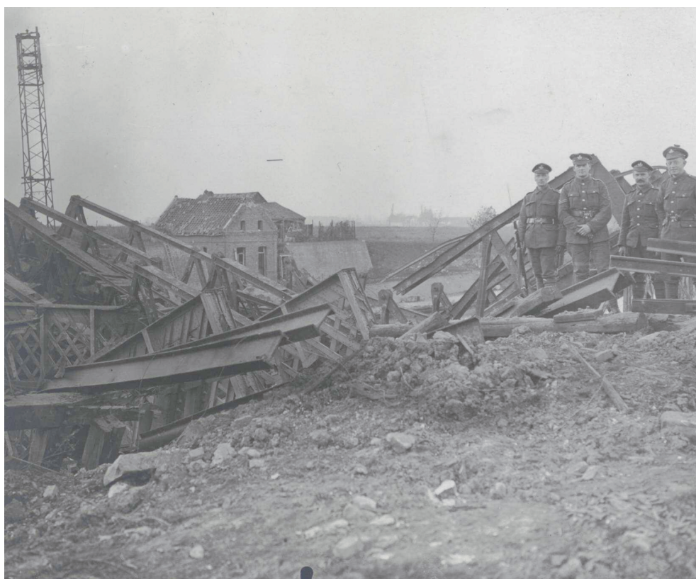
Fig. 2 : Un pont détruit par les Allemands avant leur retraite à Corbehem, 5 km au sud de Douai. 31 octobre 1918 (coll. La Contemporaine VAL 301/010).
