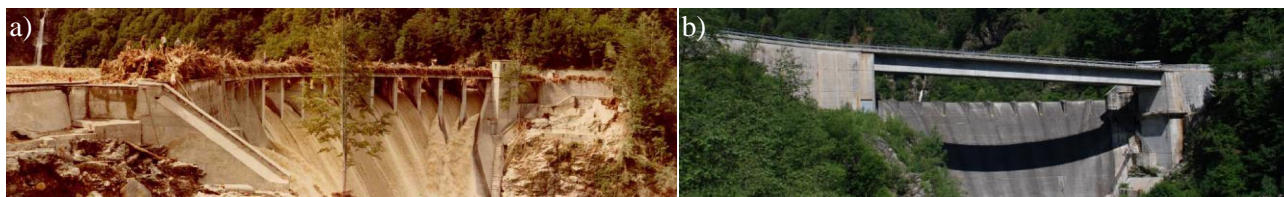
FIGURE 4.5: Adaptation de l’évacuateur de crue du barrage de Palagnedra (Suisse) : a) obstruction généralisée, surverse et contournement de l’ouvrage lors d’apports massifs en flottants en 1978 ; b) nouvelle configuration de l’ouvrage dont les piles ont été découpées (Photos de Ofima tiré de CSB, 2017)
