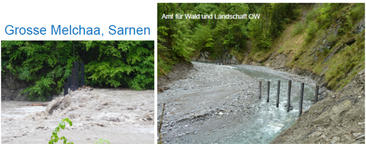
FIGURE 4.33: Exemple de grille en épi (source : GERTSCH, 2019)
