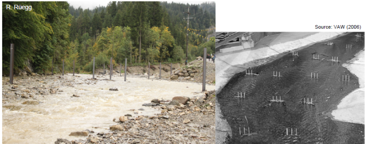
FIGURE 4.32: Exemple des pieux disposés en rivière pour du piégeage diffus (source : GERTSCH, 2019)
