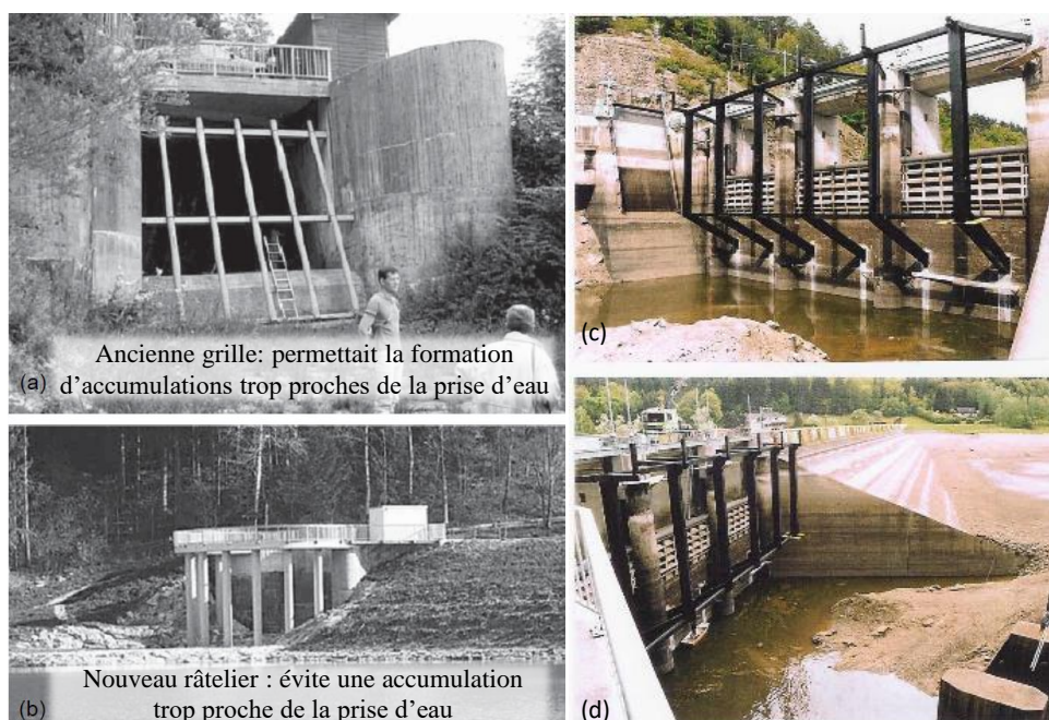
FIGURE 4.7: (a) Ancien évacuateur de crue avec grand râtelier à Grüntensee et (b) nouveaux piliers de râtelier en amont (© HARTLIEB et RUTSCHMANN, 2015); (c & d) Grand râtelier au réservoir de Thurnberg à RiverKamp en Autriche, © Photo : Ministère Fédéral de l'Agriculture, des Forêts, de l'Environnement et de la Gestion des Eaux, Autriche), toutes les images sont tirées du guide CSB (2017)
