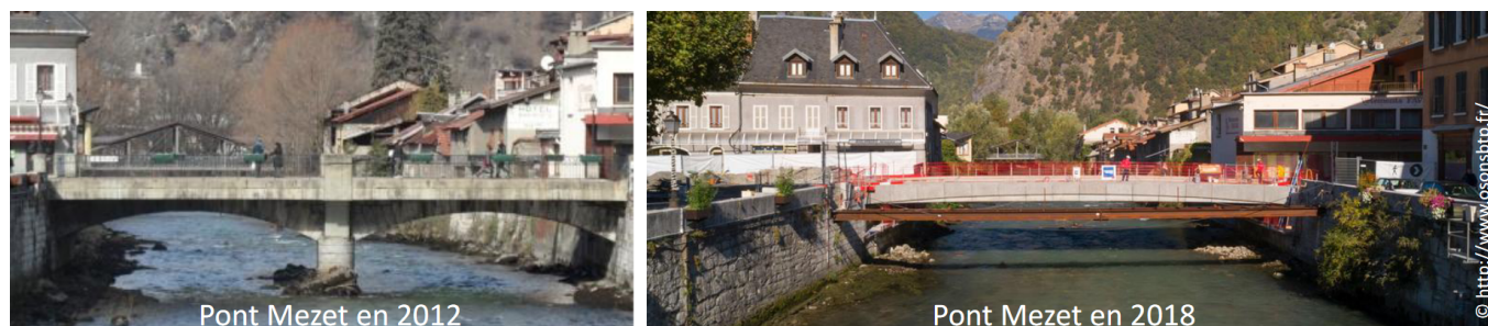
FIGURE 4.2: Pont Mezet sur l'Isère à Moûtiers (Savoie) : l'ouvrage historique avait une pile centrale (photo de gauche), il a été remplacé par un pont à travée unique (photo de droite © Regis BOUCHU/ Actophoto, photo issue de http://www.osonsbtp.fr ). Les analyses hydrauliques montraient que l'ouvrage historique permettait le passage de la crue centennale (sans revanche, avec mise en charge de l'ouvrage et en ignorant l'effet de potentiel embâcle). Malgré sa capacité hydraulique théoriquement suffisante, la cartographie du PPR considérait un scénario d'embâcle du pont, de rehausse des lignes d'eau amont et de débordement généralisé dans le centre ancien. La traversée de Moûtiers par l'Isère est équipée de plusieurs ponts mais celui-ci était le seul à être équipé d'une pile centrale et à être en charge pour la crue de référence. Il a donc été décidé de remplacer l'ouvrage par un ouvrage moins sensible aux embâcles. Le coût des travaux a été de l'ordre de 1 000 000 €HT pour ce pont de 24 m de portée, 12 m de large, supportant le passage de convois exceptionnels.
