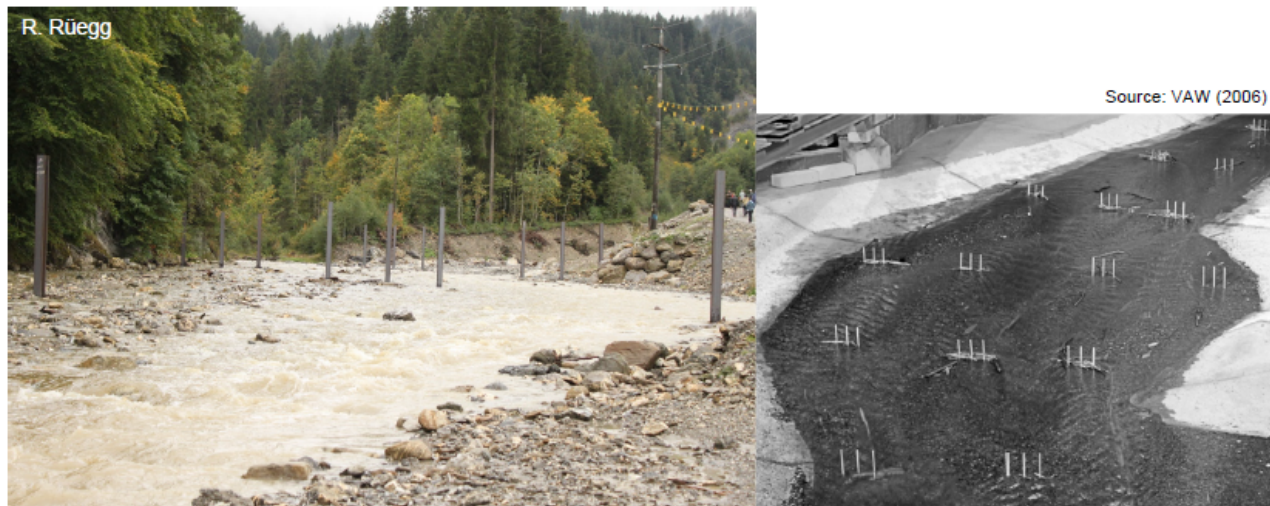
FIGURE 4.32: Exemple des pieux disposés en rivière pour du piégeage diffus (source : GERTSCH, 2019)
