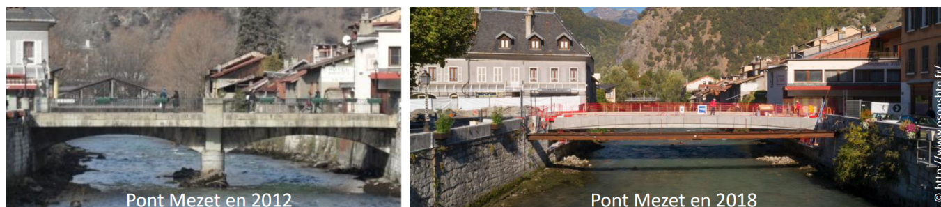
FIGURE 4.2: Pont Mezet sur l'Isère à Moûtiers (Savoie) : l'ouvrage historique avait une pile centrale (photo de gauche), il a été remplacé par un pont à travée unique (photo de droite © Regis BOUCHU/ Actophoto, photo issue de http://www.osonsbtp.fr ). Les analyses hydrauliques montraient que l'ouvrage historique permettait le passage de la crue centennale (sans revanche, avec mise en charge de l'ouvrage et en ignorant l'effet de potentiel embâcle). Malgré sa capacité hydraulique théoriquement suffisante, la cartographie du PPR considérait un scénario d'embâcle du pont, de rehausse des lignes d'eau amont et de débordement généralisé dans le centre ancien. La traversée de Moûtiers par l'Isère est équipée de plusieurs ponts mais celui-ci était le seul à être équipé d'une pile centrale et à être en charge pour la crue de référence. Il a donc été décidé de remplacer l'ouvrage par un ouvrage moins sensible aux embâcles. Le coût des travaux a été de l'ordre de 1 000 000 €HT pour ce pont de 24 m de portée, 12 m de large, supportant le passage de convois exceptionnels.
