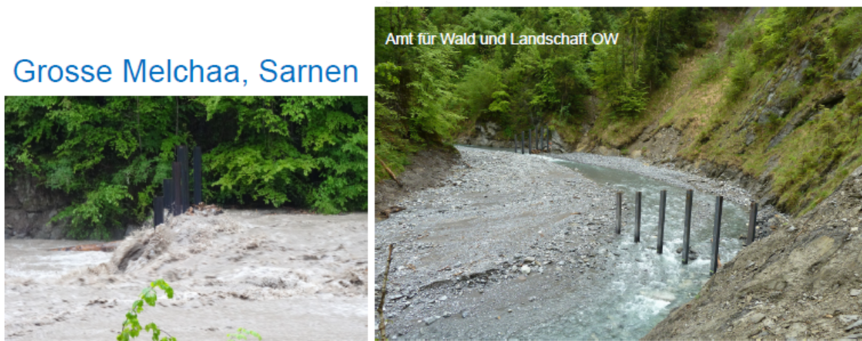
FIGURE 4.33: Exemple de grille en épi (source : GERTSCH, 2019)
