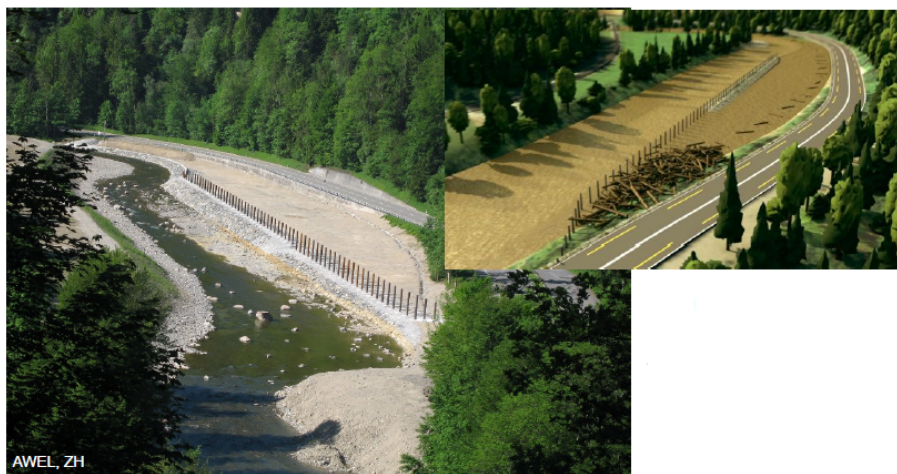
FIGURE 4.35: Image et infographie de l'ouvrage construit (source : GERTSCH, 2019)
