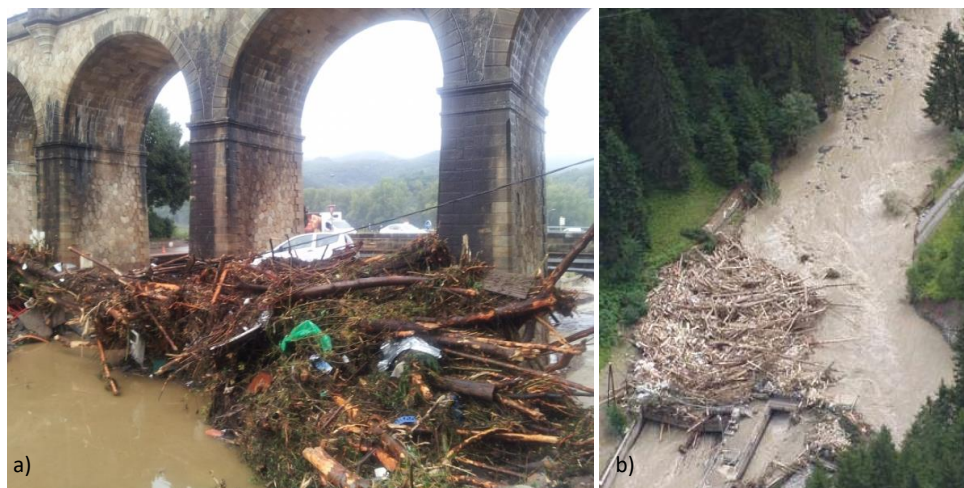
FIGURE 3.7: Exemples d'embâcles multi-couches : denses, développés dans l'épaisseur (a) sur le Bitoulet (Hérault) après la crue de Septembre 2014 (Source ©Midi Libre) et (b) sur une prise d'eau de la rivière alpine Trisanna (Tyrol) pendant les crues de 2005 (Source : RUDOLF-MIKLAU et HÜBL, 2010).
