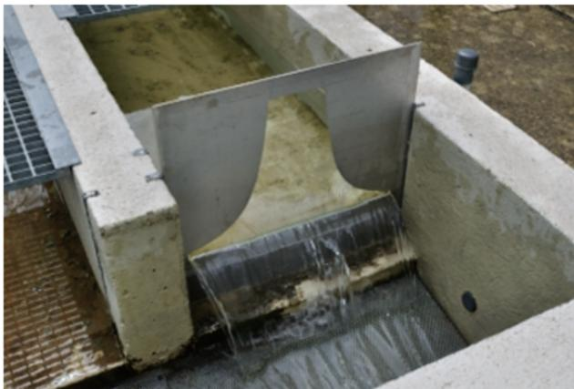
La forme du déversoir est déterminée en puissance  $^{-1/2}$  de façon à ce que la relation  $Q(h)$  soit linéaire.
