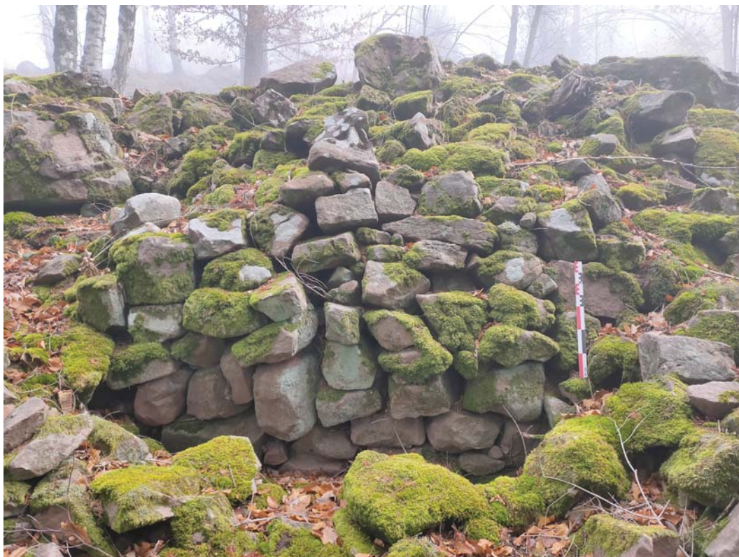
Fig. 6. Vue du parement de l'enceinte à l'ouest. Cliché : F. Minot
