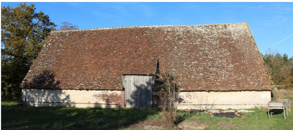
Figure 12 : Exemple de grange à la Charterie (Saint-Arnoult) dont les maçonneries ont été entièrement refaites au 20<sup>e</sup> siècle
