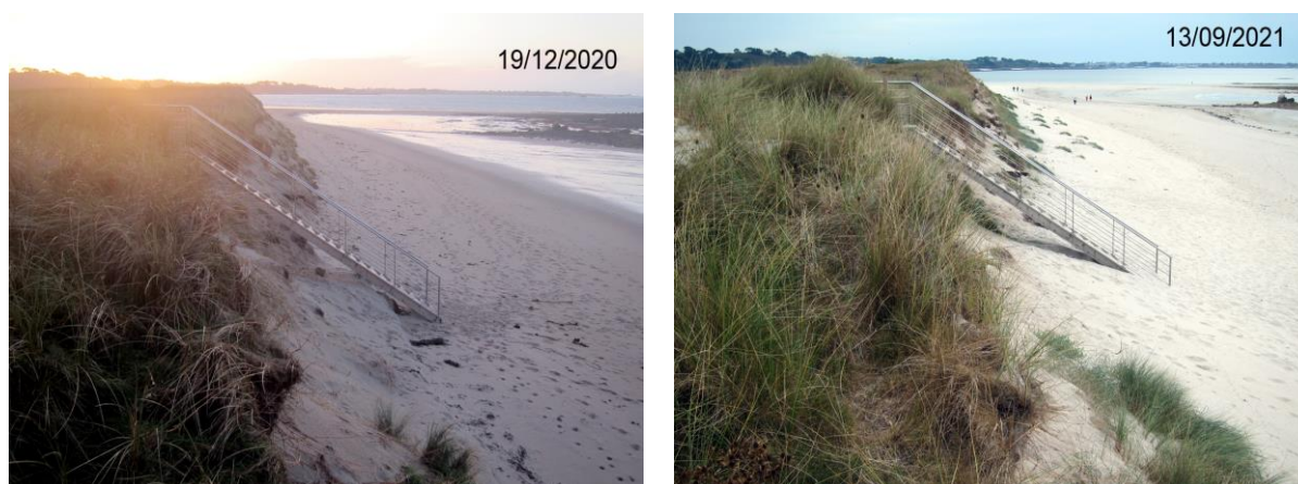
Figure 7 – Engraissement du cordon dunaire de la plage du Curnic (au niveau de l'escalier amovible d'accès au camping) durant l'année 2021.
