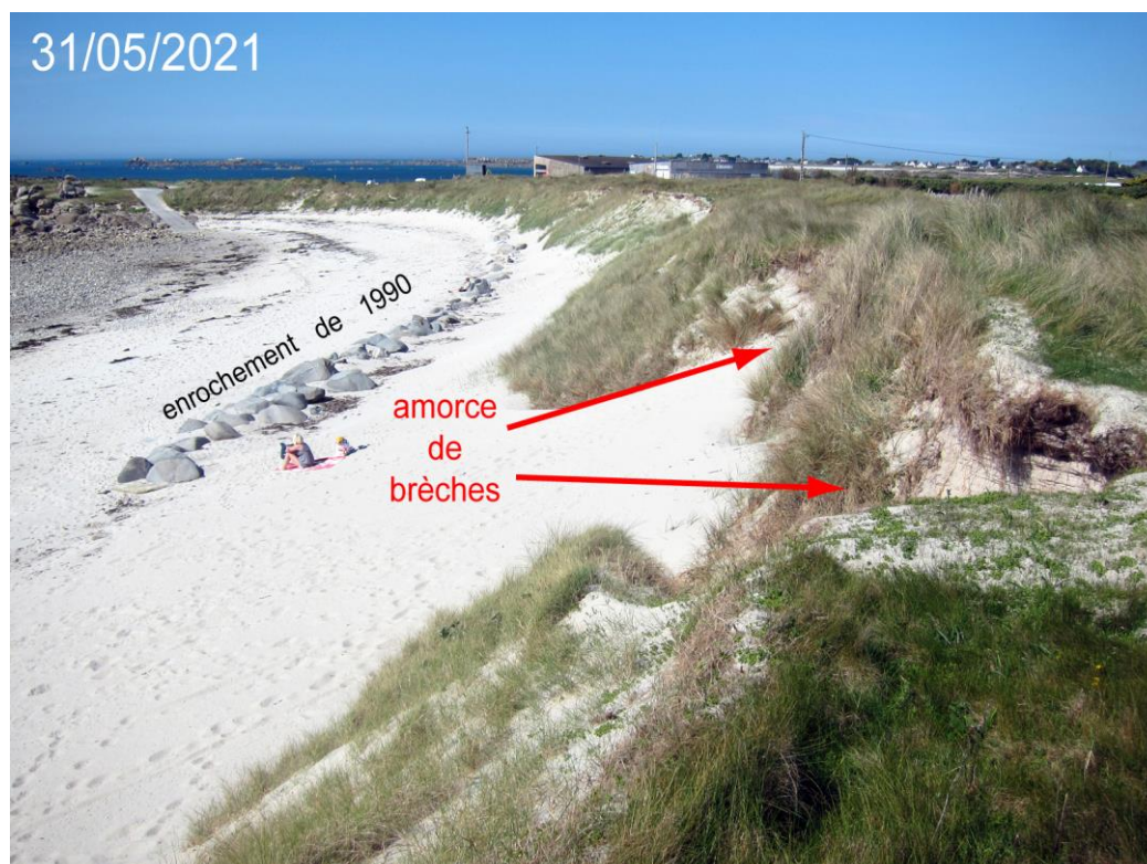
Figure 10 – Amorce d’ouverture de deux brèches dans la partie la plus orientale de la plage du Curnic (photo prise le 31 mai 2021).
