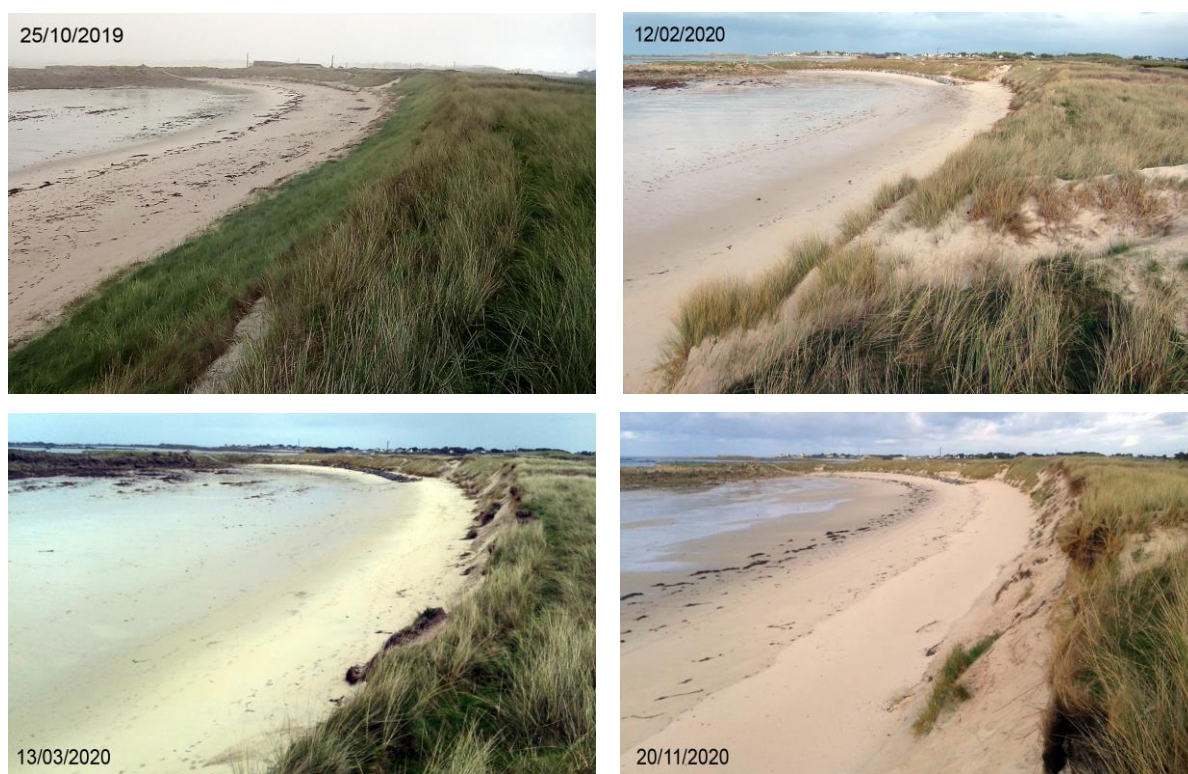
Figure 6 – Erosion du cordon dunaire de la plage du Curnic (partie orientale du secteur d'étude) durant l'année 2020. Cette érosion est liée au 3 tempêtes Ciara du 9/02/2020, Inès du 13/02/2020, et du 15/11/2020.
