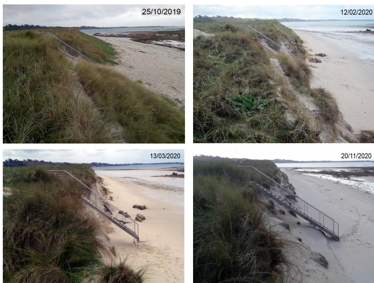
Figure 7 – Erosion du cordon dunaire de la plage du Curnic (au niveau de l'escalier amovible d'accès au camping) durant l'année 2020. Cette érosion est liée au 3 tempêtes Ciara du 9/02/2020, Inès du 13/02/2020, et du 15/11/2020.
