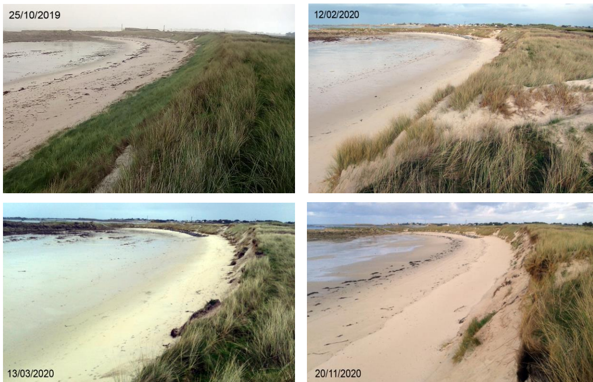
Figure 6 – Erosion du cordon dunaire de la plage du Curnic (partie orientale du secteur d'étude) durant l'année 2020. Cette érosion est liée au 3 tempêtes Ciara du 9/02/2020, Inès du 13/02/2020, et du 15/11/2020.
