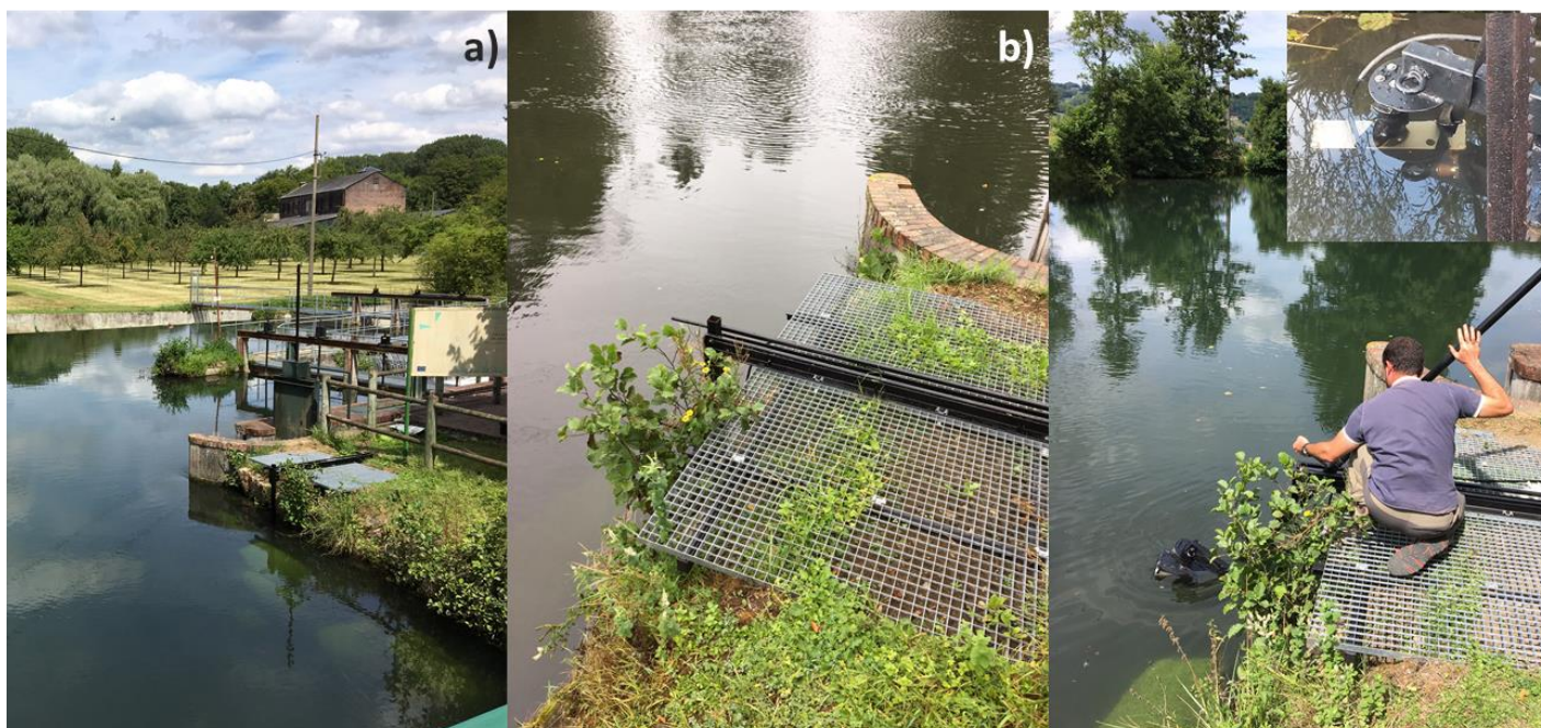
Figure 5: Dispositif d'accueil de la ARIS sur le site de Breuil en Auge, a) structure d'accueil, b) support fixé en berge, c) fonctionnement de la perche mobile et d) fixation de la caméra acoustique sur la perche.
