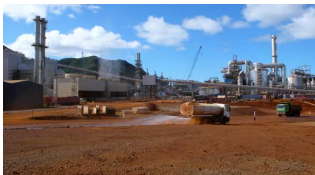
Usine hydrométallurgique sur le site de Goro, société minière Prony ressources, Nouvelle-Calédonie © Boré J.-M., IRD
