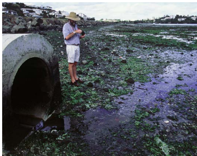
Émissaire d'eaux usées provoquant l'efflorescence d'algues vertes de la famille des Ulves dans la baie de Sainte-Marie à Nouméa en 1997, Nouvelle-Calédonie © Garrigue C., IRD
