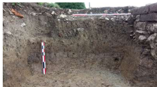
Fig. 84. Coupe réalisée sur la berme 2. Entre le niveau de cailloutis Fait 10 et le Fait 13, on distingue l'US2515. A droite, dans l'angle entre le mur et la berme, on perçoit aussi le creusement de fondation du mur MR4.
