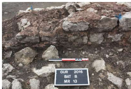
Fig. 108. Détail du mortier du mur MR13
