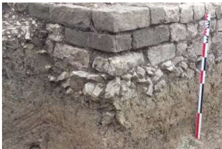
Fig. 104. Les fondations à l'extérieur du bâtiment dans l'angle sud. Elles reposent et recoupent le Fait 13. On perçoit aussi l'angle du mur ouvragé en grès rose.
