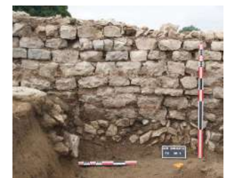
Fig. 94. Les fondations du mur MR5 (face sud)
