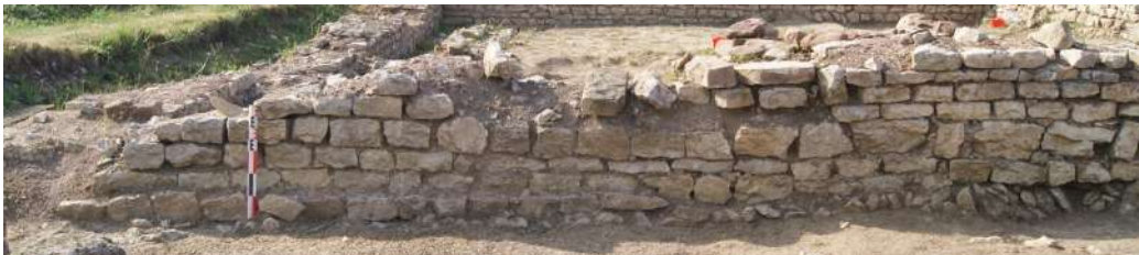
Fig. 101. MR7 face nord dans pièce 3 avec ouverture comblée
