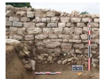
Fig. 94. Les fondations du mur MR5 (face sud)
