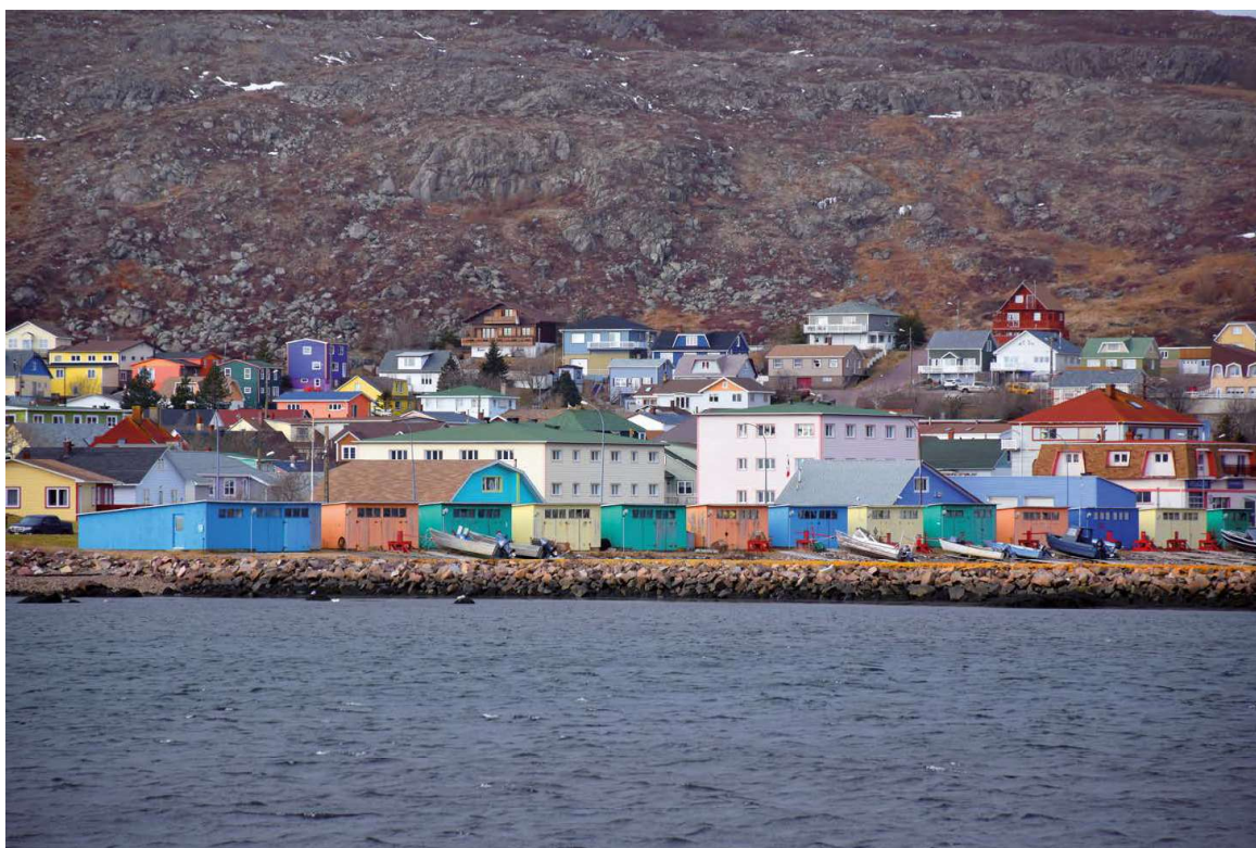
Figure 3 – Les zones basses du littoral de la ville de Saint-Pierre protégées par de nombreux enrochements.
