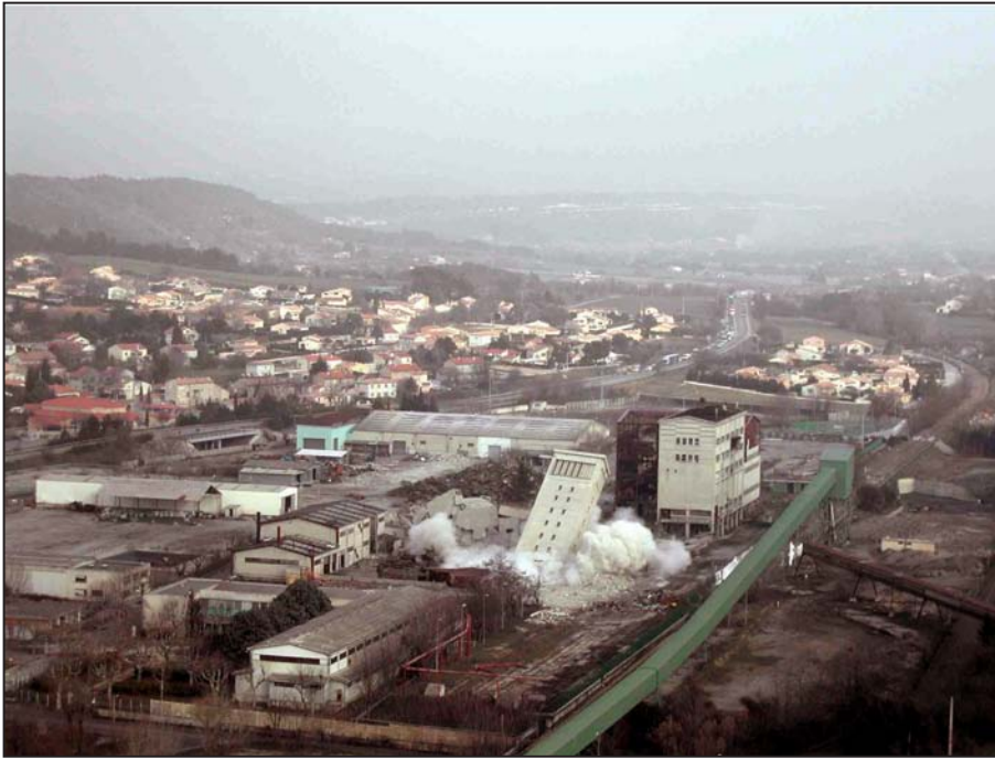
Fig. 54 et 55. Destruction des tours d'extraction et de service des puits Courau et Boyer à Meyreuil, février 2004, et vue du site après mise en sécurité. Cl. CdF J.-M. Domanget - R. Monteau.
