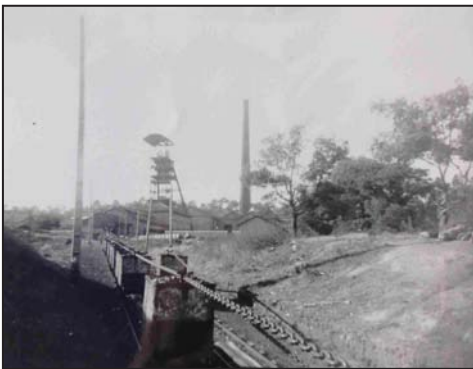
Fig. 35. Vue du traînage mécanique du puits Hély d'Oissel (Coll. Part.). Repro. T. Lochar.
