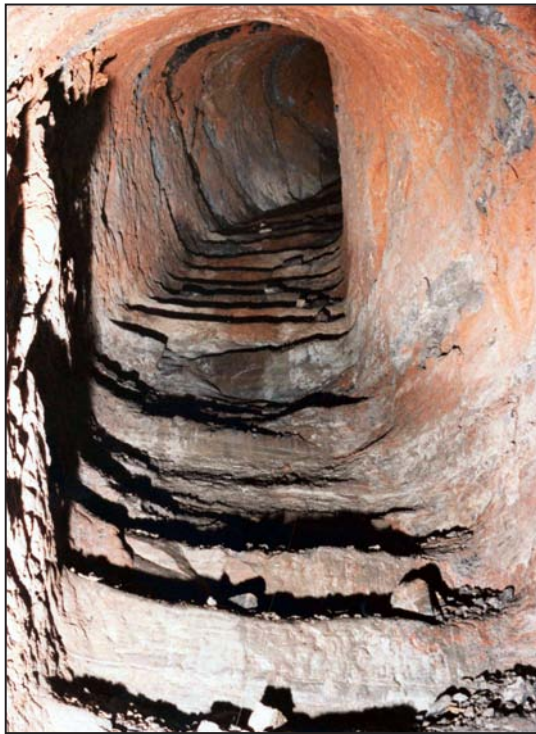
Fig. 25. Descenderie associée au puits Saint-Joseph à Cadolive pour la descente des mineurs. Cl. CdF R. Monteau, vers 1990.
