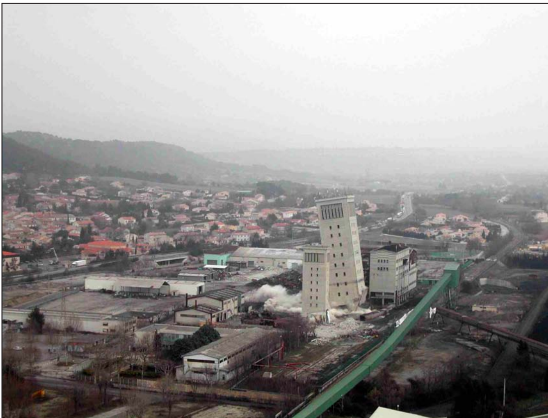
Fig. 53. Destruction des tours d'extraction et de service des puits Courau et Boyer à Meyreuil, février 2004. Cl. CdF J.-M. Domanget - R. Monteau.
