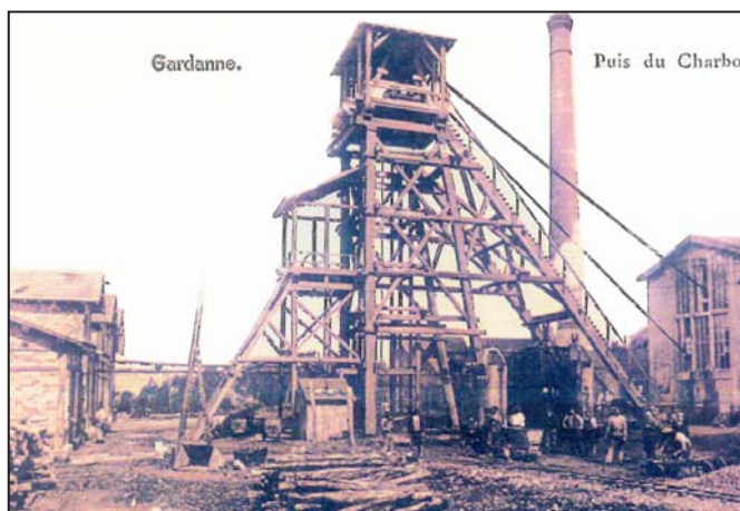
Fig. 18. « Gardanne. Puits de charbonnage », carte postale ancienne (Coll. part.). Vue du chevalement en bois du puits Biver.
