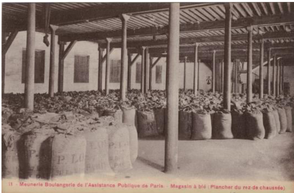
Figure 24 : Carte postale ancienne. Meunerie boulangerie de l'Assistance publique de Paris. 11- Magasin à blé (plancher du rez-de-chaussée). Ed. A. Bréger Frères, Paris. © Coll. JP Martin.
