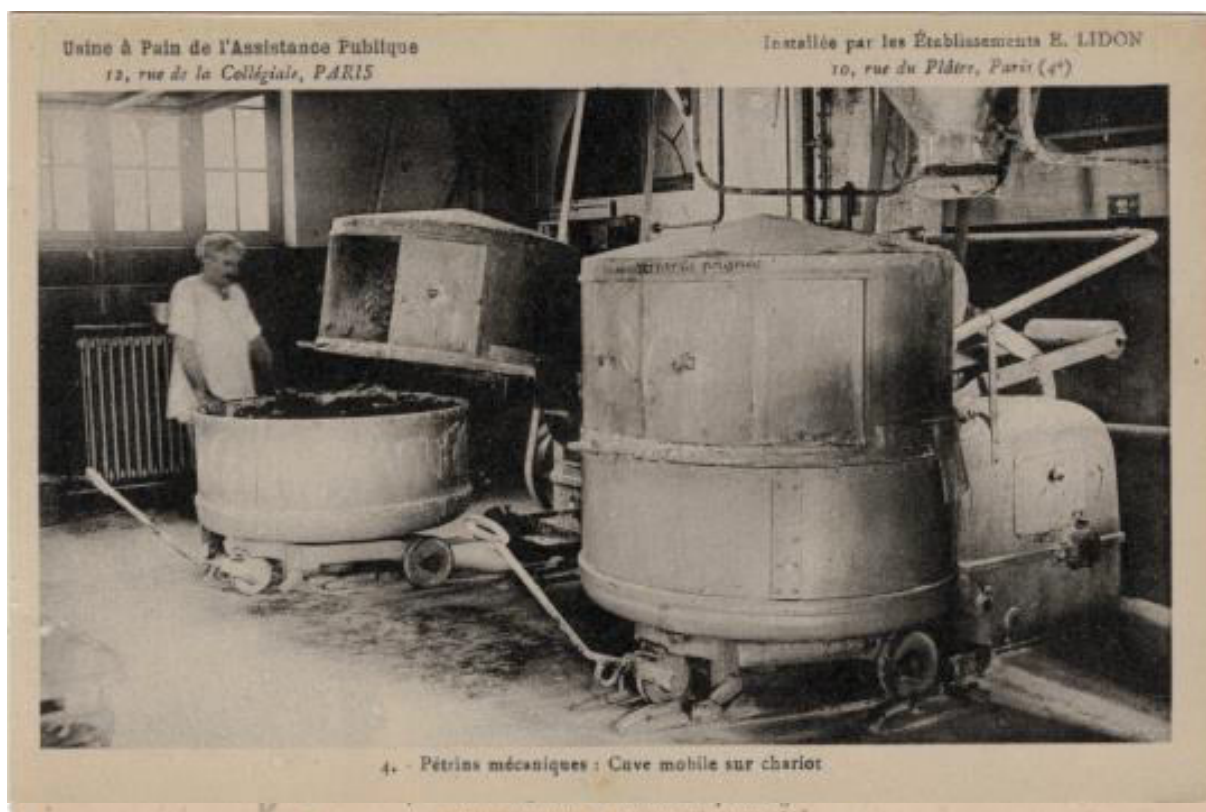
Figure 32 : Carte postale ancienne. Usine à pain de l'Assistance Publique, 12 rue de la Collégiale, Paris. Installée par les établissements E. Lidon, 10 rue du Plâtre, Paris (4e). 4 – Pétrins mécaniques, cuve mobile sur chariot. © Coll. JP Martin.
