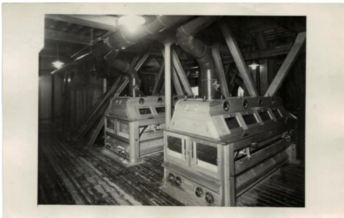
Figure 26 : Sasseur pour le tamisage des farines. Cliché n° 544 N de la Photographie Industrielle Noblecourt, Paris. Service technique du plan de Paris. Cliché pris en Mai 1943. © Coll. JP Martin.
