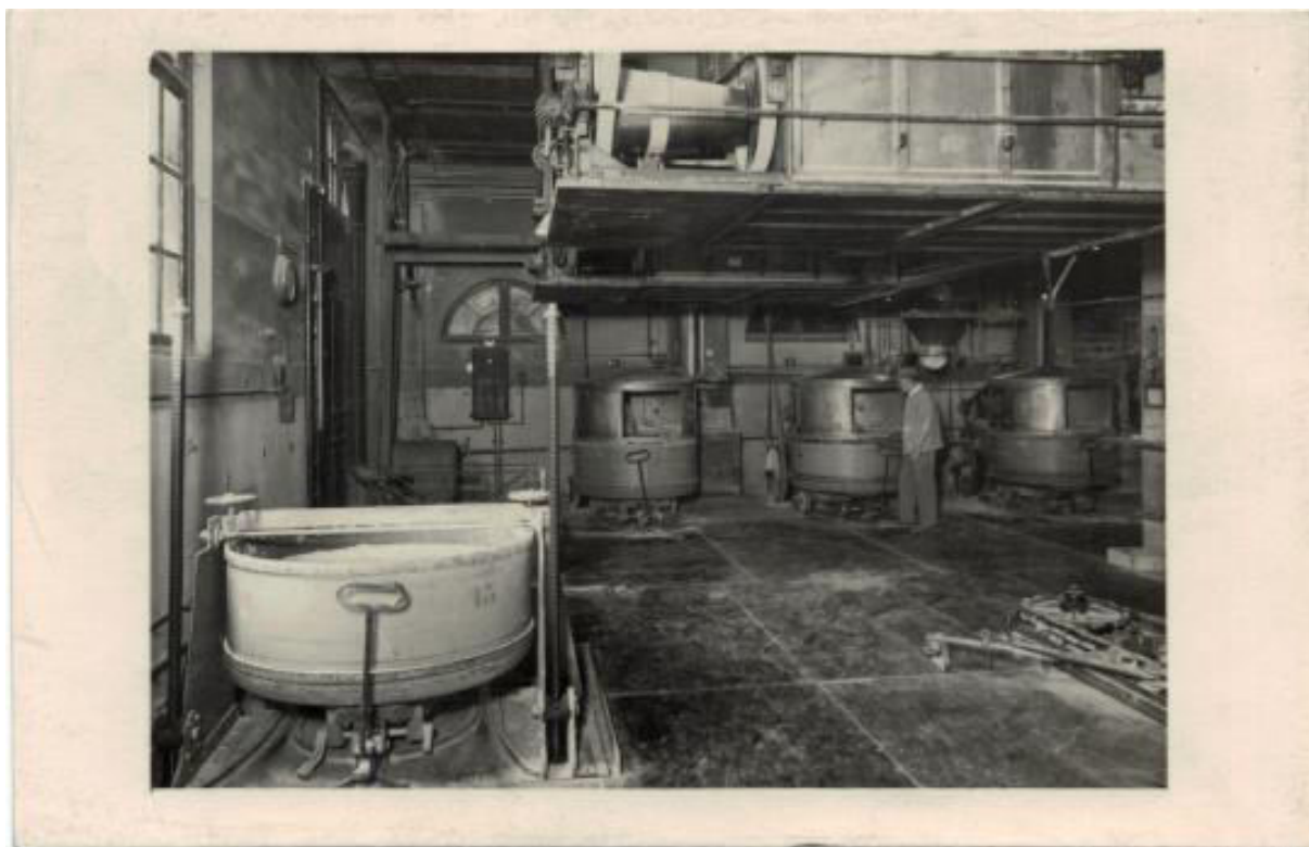
Figure 30 : Pétrins mécaniques. Cliché n° 544 N de la Photographie Industrielle Noblecourt, Paris. Service technique du plan de Paris. Cliché pris en Mai 1943. © Coll. JP Martin.
