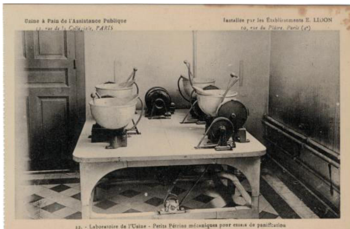
Figure 51 : Carte postale ancienne. Usine à pain de l'Assistance Publique, 12 rue de la Collégiale, Paris. Installée par les établissements E. Lidon, 10 rue du Plâtre, Paris (4e). 12 –Laboratoire de l'usine. Petits pétrins mécaniques pour essais de panification. © Coll. JP Martin.
