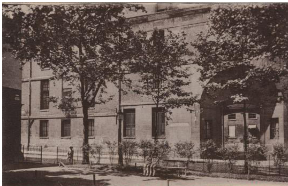
Figure 12 : Carte postale ancienne. Meunerie-boulangerie de l'Assistance Publique de Paris. 1- Ancienne entrée principale sur la rue Scipion. Ed. A. Bréger Frères, Paris. © Coll. JP Martin.
