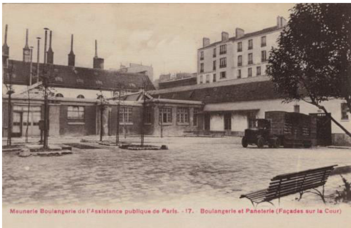
Figure 50 : Carte postale ancienne. Meunerie boulangerie de l'Assistance publique de Paris. 17- Boulangerie et Paneterie. Ed. A. Bréger Frères, Paris. (Sortie de la remorque chargée du quai de la paneterie). © Coll. JP Martin.
