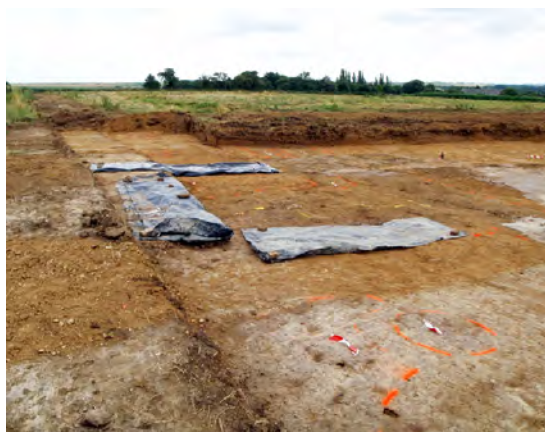
Figure 18 : Mise en place de protection pour les solins
