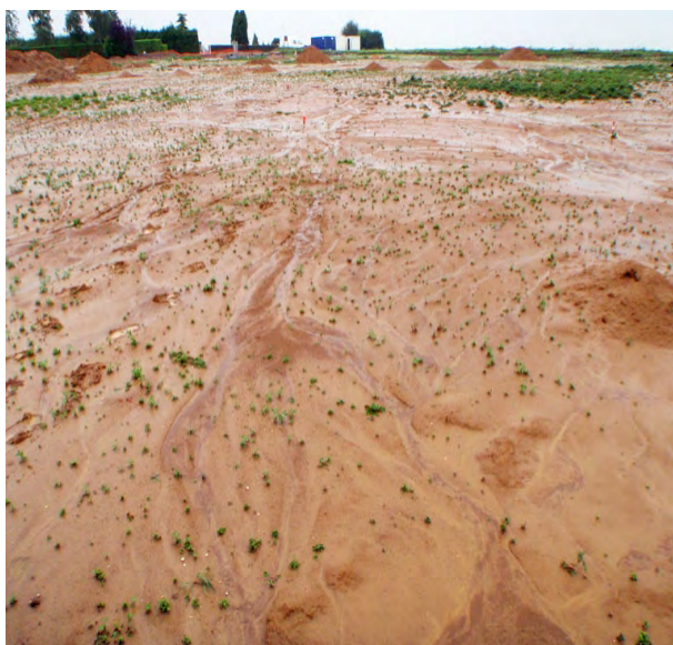
Figure 21 : colluvions après un orage
