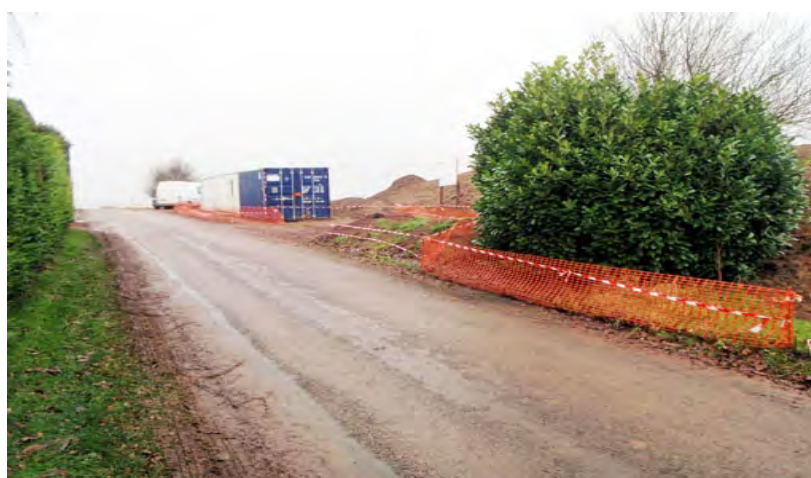
Figure 14 : Installation des bungalows et de la signalisation
