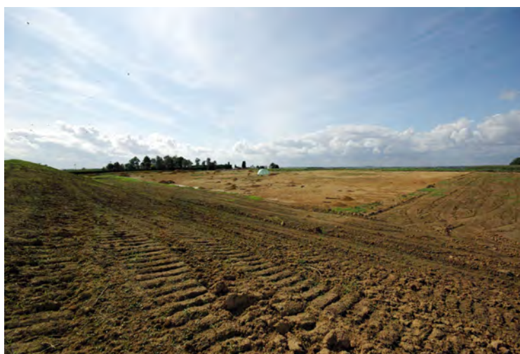
Figure 16 : Vue de la première partie du décapage depuis l'angle nord-est
