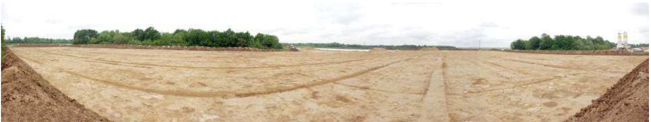
Figure 22 : Vue générale du site entièrement décapé.
