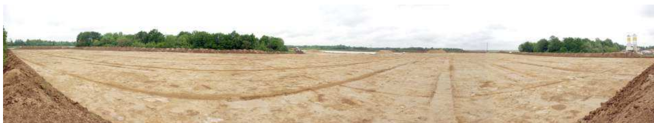
Figure 22 : Vue générale du site entièrement décapé.
