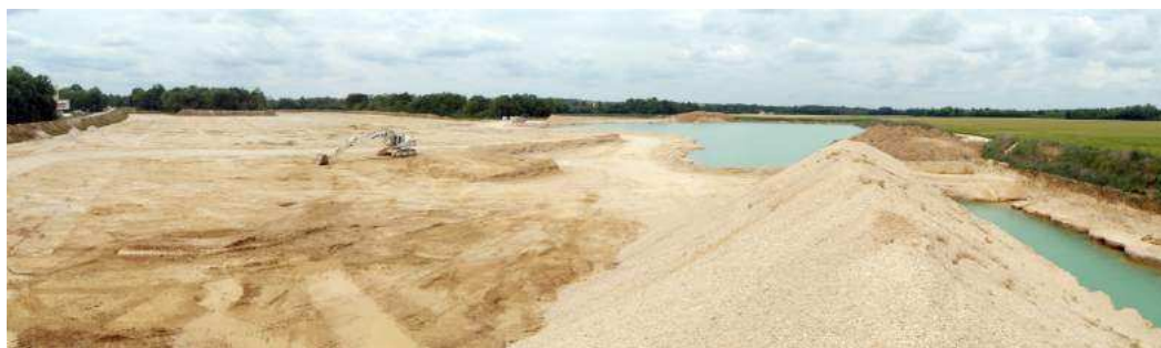
Figure 27 : Parcelles libérées (au premier plan l'extraction est déjà en cours, en arrière plan, la nappe phréatique remonte à l'ouverture de la gravière).
