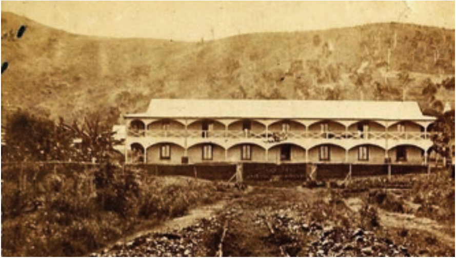
Image 37. L'hôpital des déportés à la presqu'île Ducos ( http://www.clocherobecourt.com/Robecourt/NC/NoumeaCville.php )
