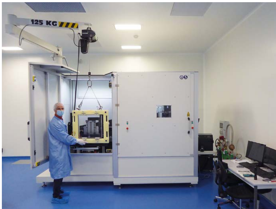
Figure 4. Photo d'un opérateur installant un hublot de chambre en cadre dans la machine de micro-usinage par laser CO 2 installée dans un bâtiment proche du LMJ.
