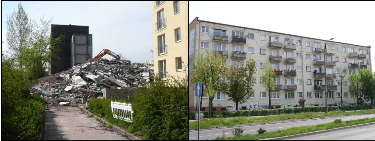
Frontière germano-polonaise : la question du logement Photo de gauche : Rénovation urbaine à Francfort-sur-Oder, Land de Brandebourg Photo de droite : Immeuble dégradé à Slubice, voïvodie de Lubusz © Kamieniczna A., 2008
