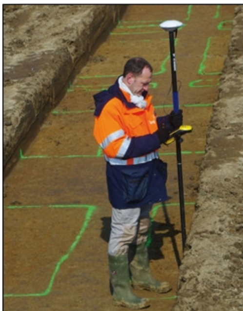
Figure 19 : Lever de points topographiques avec un appareil de géopositionnement sur un chantier de l'Inrap (© Denis Gaillard, Inrap)
