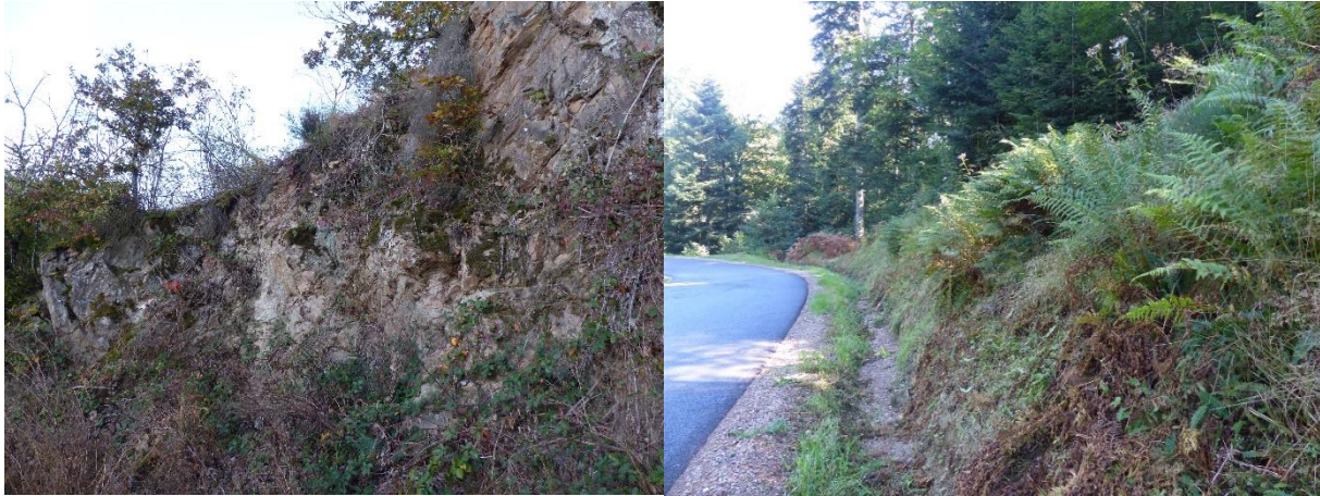
Figure 7 : Paroi rocheuse en bord de route
