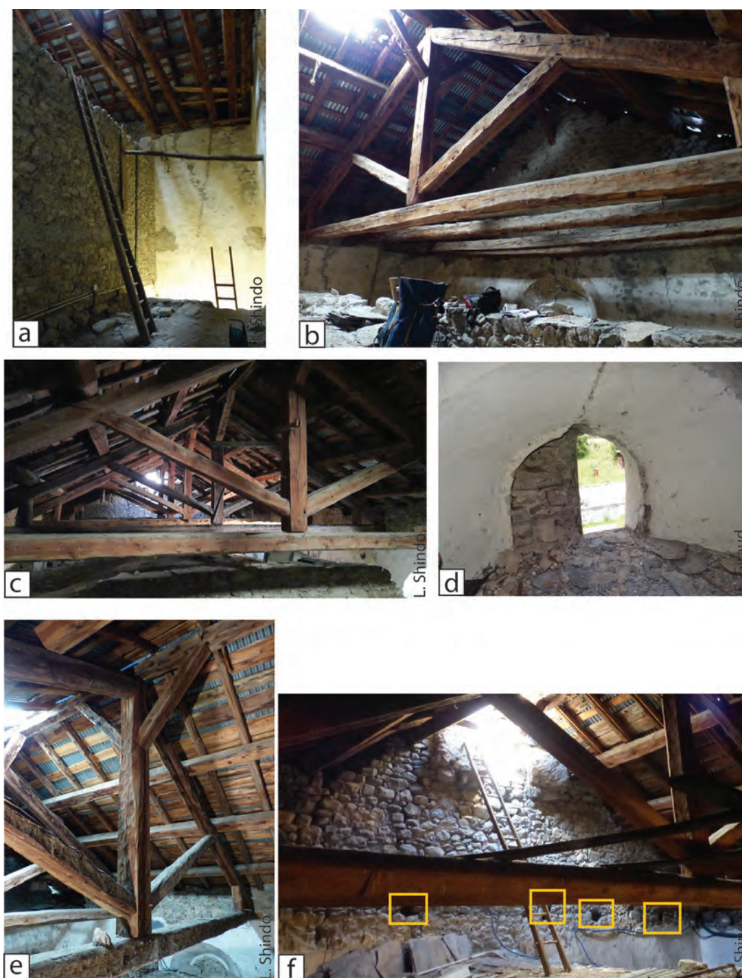
Figure 4 : a- Revers des voûtes de la sacristie, vue depuis le sud-est. Les peintures « protestantes » sont sur le mur est (à droite, non visible). Cet espace est couvert de quatre « tirants » orientés nord-sud sous lesquels sont toujours fixées des planches, dans leur partie nord (Photo : L. Shindo), b- Première ferme en partant de l'est (non carottée) et, derrière celle-ci, les quatre « tirants ». Sur le mur du chevet en arrière-plan, partie supérieure de l'arc en plein cintre de la baie axiale condamnée et son décor de rinceaux (Photo : L. Shindo), c- Charpente des combles, vue depuis l'est. En bas à droite, baie partiellement obturée (Photo : L. Shindo), d- Deuxième baie du mur nord, en partant du sud. Plus haute que la voûte du chœur et partiellement obturée par un contrefort (vue depuis le sud) (Photo : E. Giraud), e- Deuxième ferme en partant du sud, vue depuis le nord-ouest (Photo : L. Shindo), f- Revers du mur pignon ouest, avec cinq cavités aménagées dans la maçonnerie. La cinquième, au sud, n'est pas visible sur la photo (vue depuis le sud-est) (Photo : L. Shindo).
