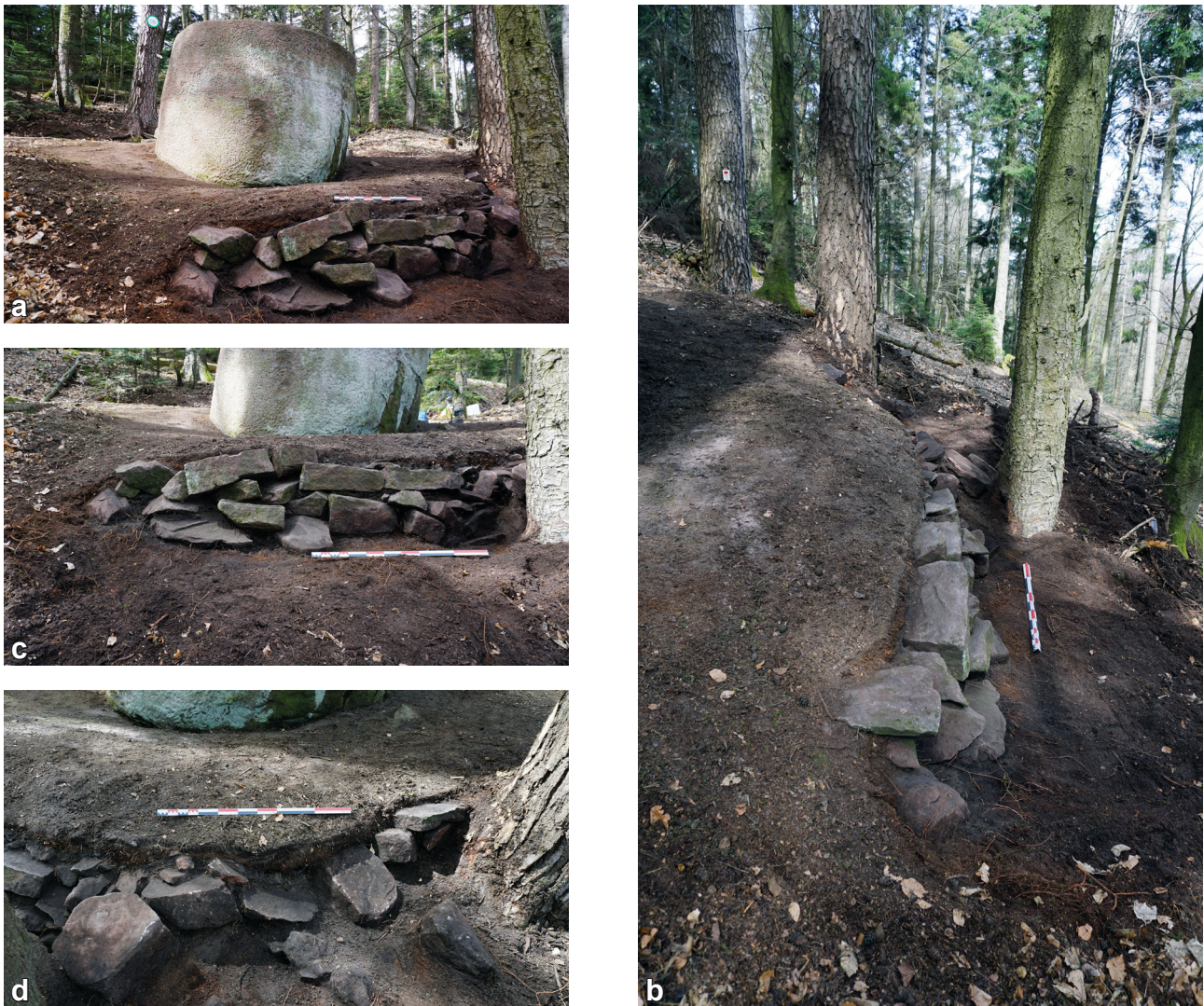
Fig. 38 : Vue générale du muret (a), de son tracé (b) et détail des parties nord (c) et sud (d)
