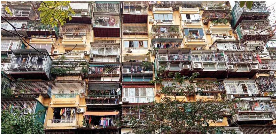
[b] Extensions dans un immeuble KTT, 2019, Hanoi.
