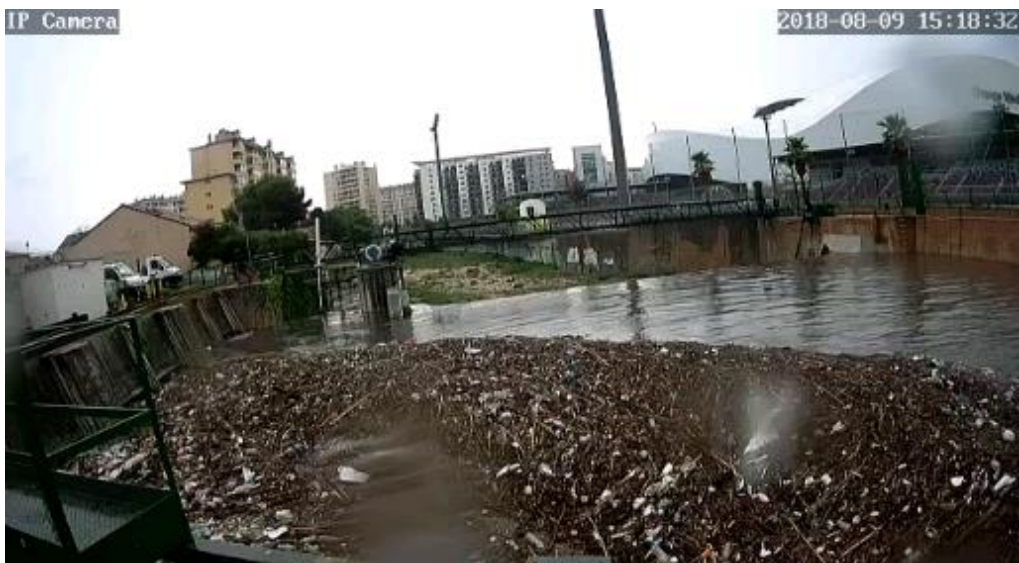
Photo 4 : Pugette par temps de pluie exceptionnel (Huveaune ; ©Eric Blin, Suez). Photo prise au début de l'évènement menant à une surverse au niveau de la vanne barrage (au centre de l'image). Noter la quantité impressionnante de débris charriés par les eaux au niveau des dégrilleurs, au premier plan.
