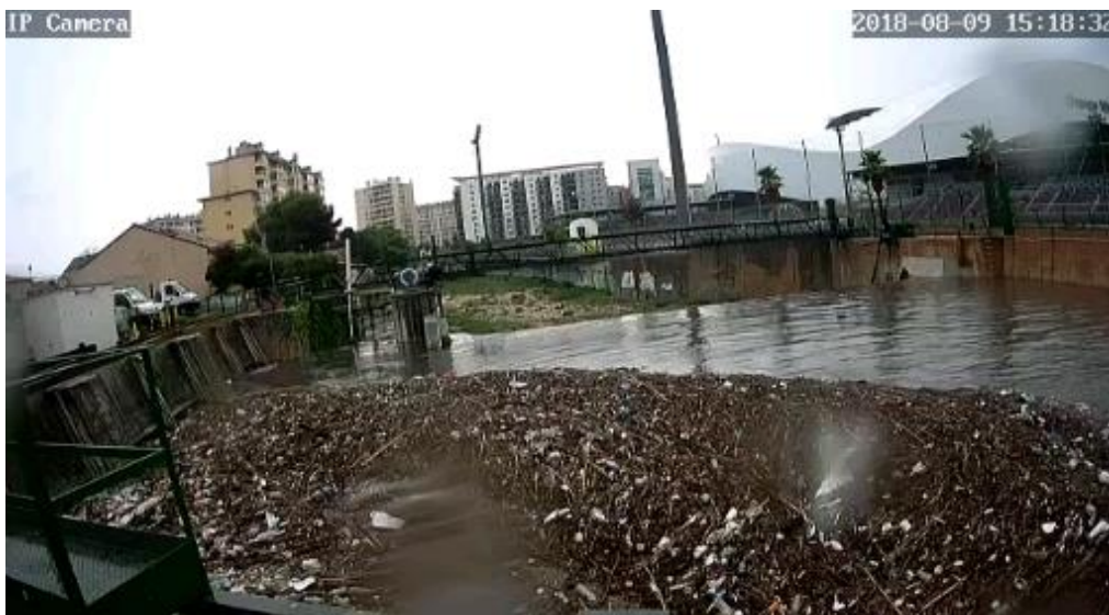
Photo 4 : Pugette par temps de pluie exceptionnel (Huveaune ; ©Eric Blin, Suez). Photo prise au début de l'évènement menant à une surverse au niveau de la vanne barrage (au centre de l'image). Noter la quantité impressionnante de débris charriés par les eaux au niveau des dégrilleurs, au premier plan.
