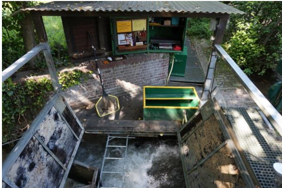
Figure 10: Vue du piège de montée en fonctionnement
